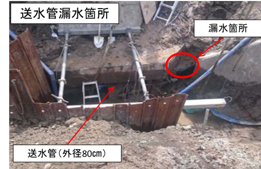
送水管漏水状況
