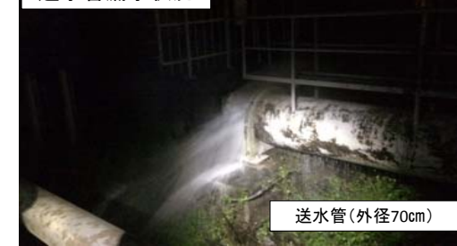
送水管漏水状況
