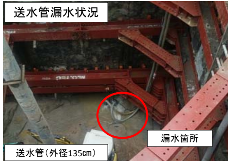
送水管漏水箇所
