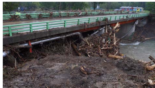
南富良野町水管橋破損
