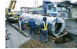
導水管布設状況φ1000(S形)
