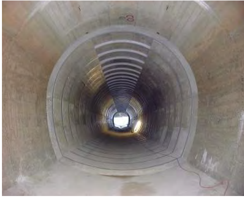
鋼製支保工+コンクリート内巻工法
