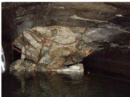
写真 2.1 崩落現場（西谷側）
