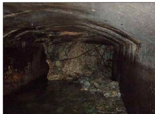
写真 2.2 崩落現場（矢野側）
