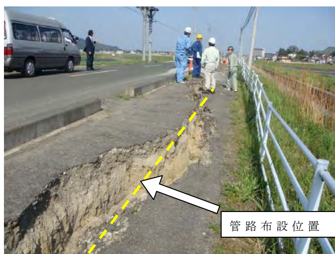
写真 4.3.3 呼び径 900 S 形 地盤沈下で被害なし
