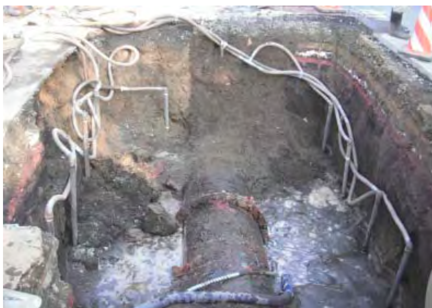
写真 4.7.2 呼び径 600 DIP K形 継手漏水
