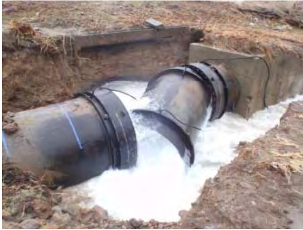
写真 4.3.1 呼び径 2400 SP 可とう管漏水
