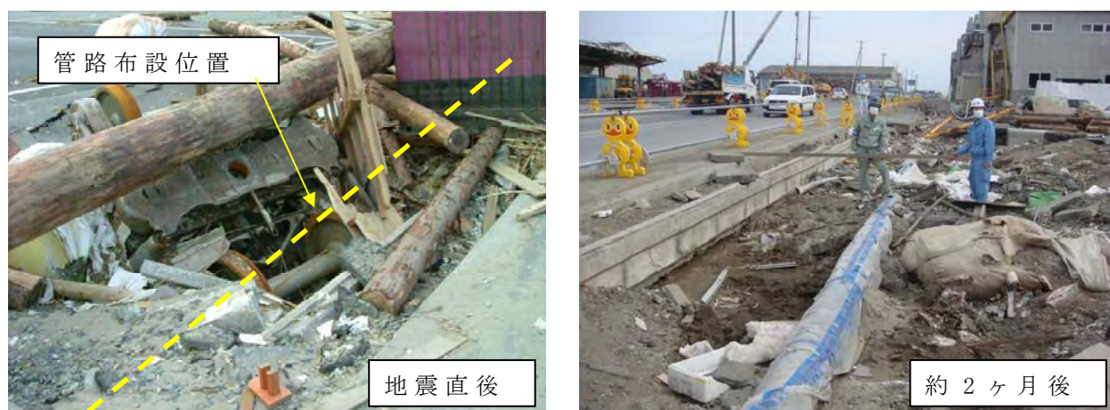
写真 4.4.2 呼び径 300 NS 形 津波による地盤洗掘の状況
