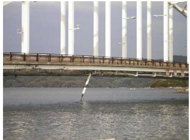
写真 5.3.2 万石橋添架管の被災状況
