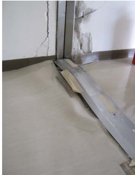
■国見浄水場 ろ過池支柱亀裂
