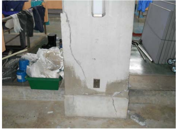
■国見浄水場 ろ過池支柱亀裂
