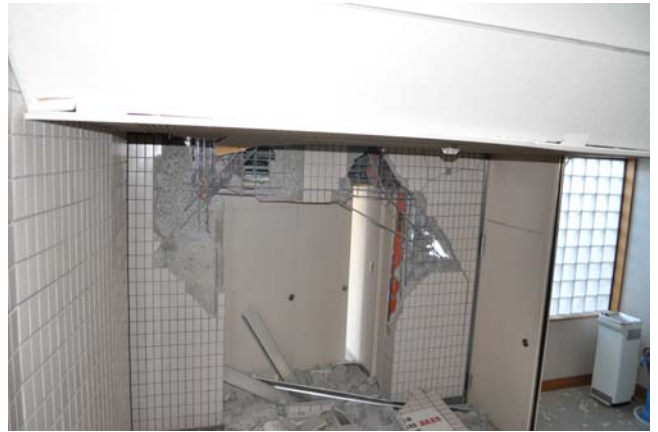
■水道局庁舎 開口部周囲の雑壁破損
