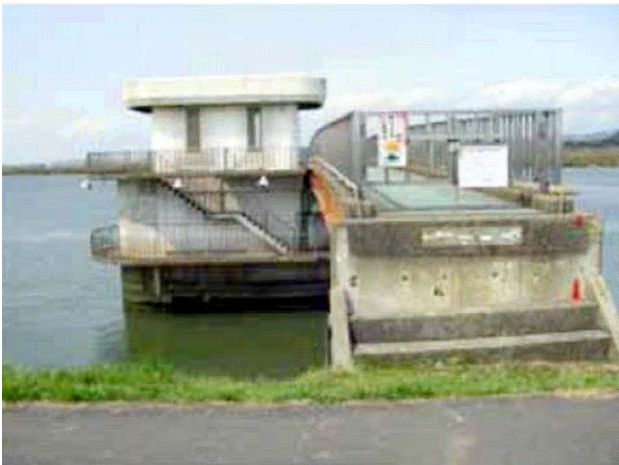
写真 5.3.1 鹿又取水場の被災状況
