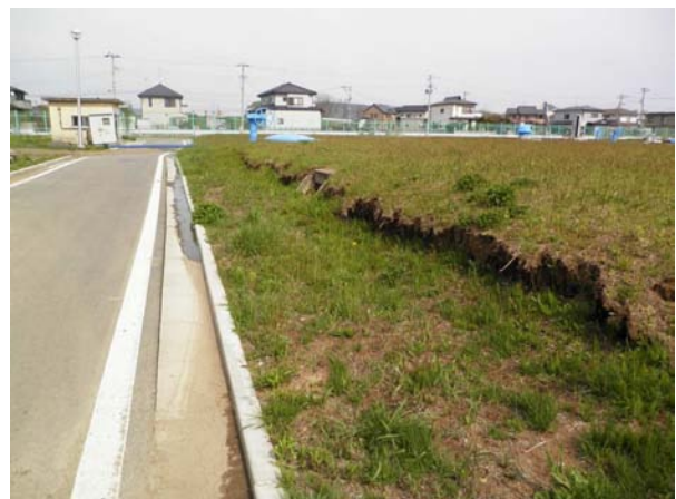
■液状化による沈下（右側は浄水池）
