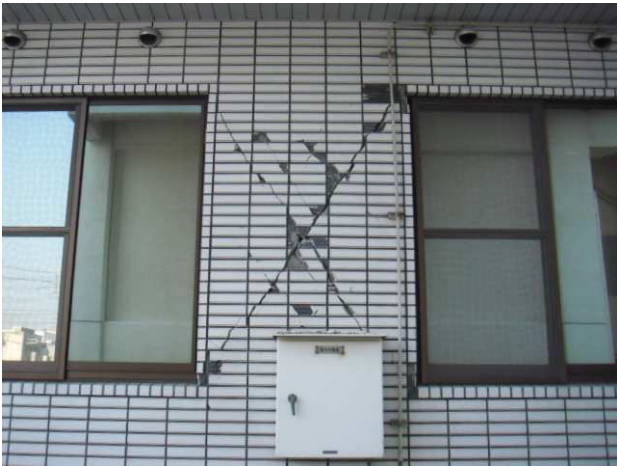
■水道局庁舎 壁の破損
