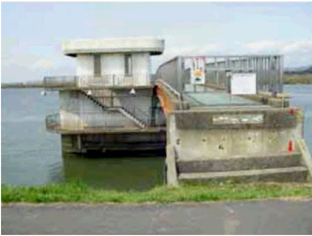
写真 5.3.1 鹿又取水場の被災状況
