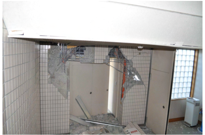
■水道局庁舎 開口部周囲の雑壁破損
