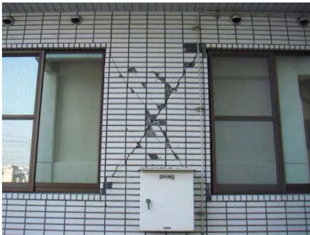
■水道局庁舎 壁の破損
