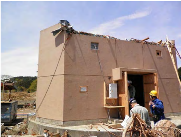
■ 取水ポンプ室（浅井戸）
