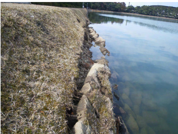
■豊田浄水場 貯水池石垣の崩れ
