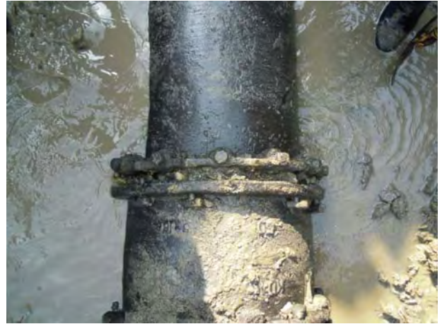
写真 4.3.2 呼び径 500 DIP K形 継手漏水
