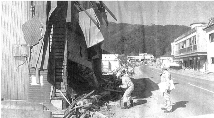
瓦礫の中での漏水調査や復旧作業が進められている (さいたま市による石巻地方(企)での応援活動)
