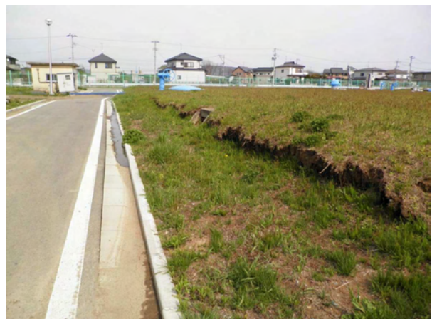
■浄水池越流管の折損状況（地盤沈下による） ■液状化による沈下（右側は浄水池）
