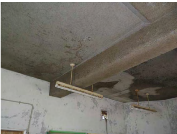
■ 取水ポンプ室の浸水跡（天井部）
