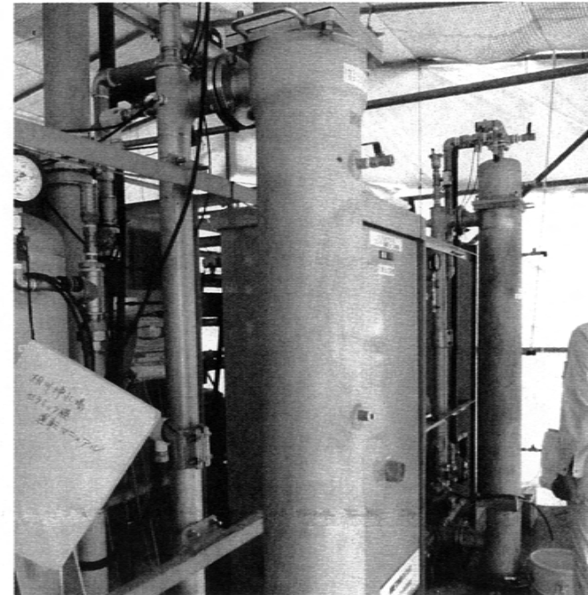
津波により水源が塩水化した石巻地方広域水道企業団の相川浄水場に設置された仮設の浄水施設（日量300立方メートル、セラミック膜）
