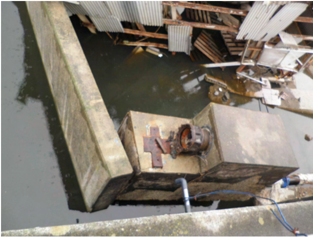
■小名浜地区 水管橋の津波被害
