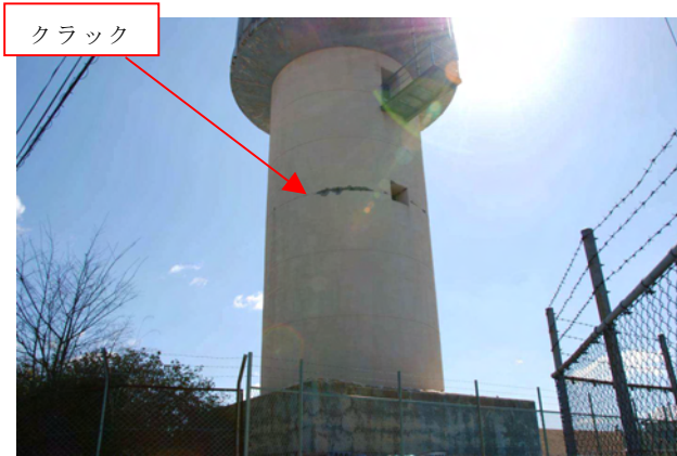
■八幡小路高架タンク 被害状況
