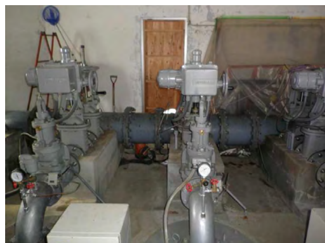
■ 取水ポンプ室の浸水跡（天井部）
