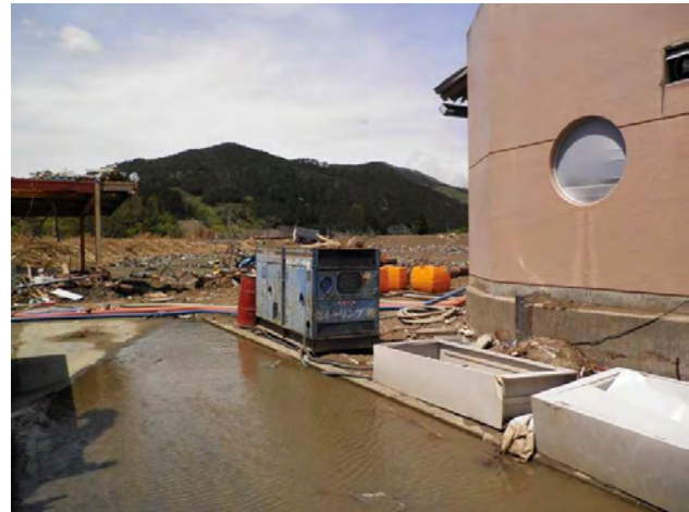
■ 自家発電設備
