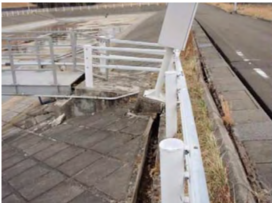
■ 中峰浄水場の被害状況
