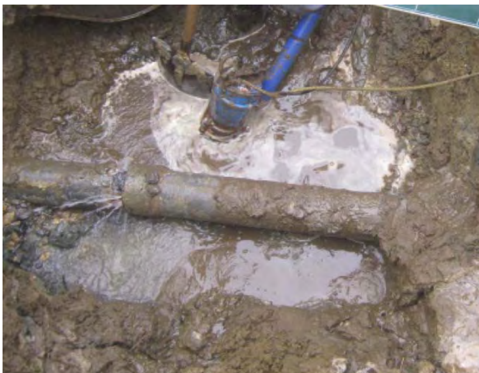
写真 4.4.1 呼び径 125 SP 継手漏水
