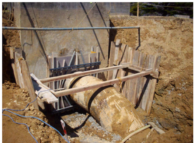
■堀口浄水場 急速混和池流出管漏水
