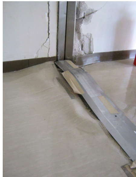
■国見浄水場 ろ過池支柱亀裂
