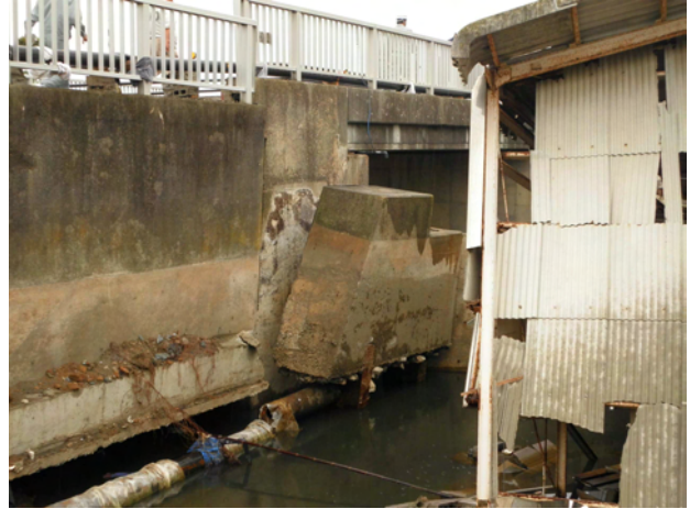
■小名浜地区 水管橋の津波被害
