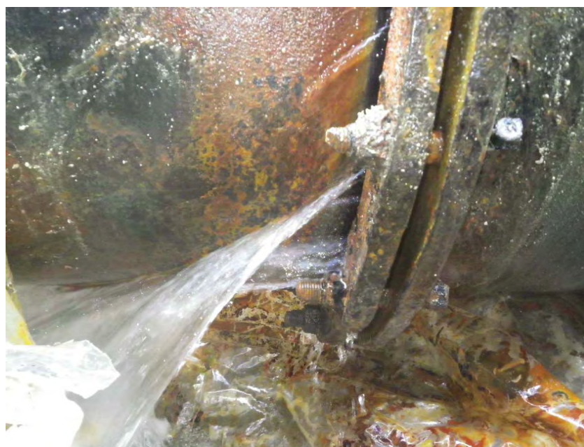
写真 4.7.1 呼び径 600 DIP K形 継手漏水
