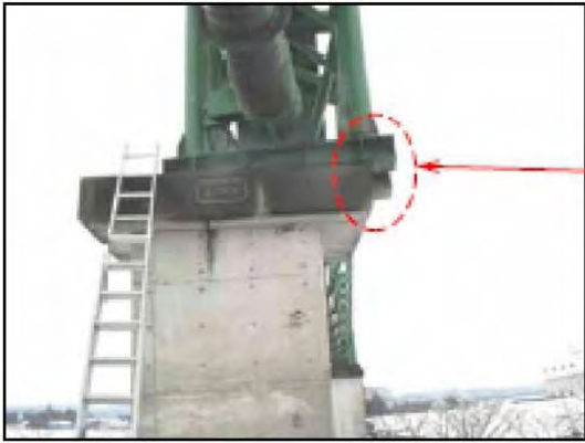
水管橋のずれ
