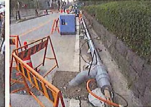
仮配管による応急復旧状況 (千葉県 習志野市)
