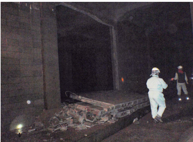
■安養寺配水所 池内導流壁一部倒壊
