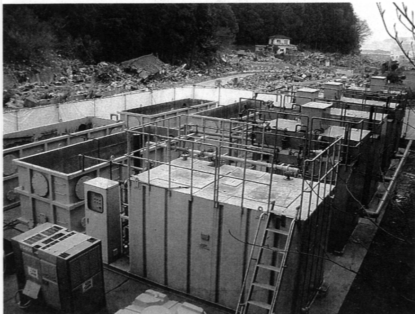
陸前高田市では、下水処理場の代替として日立プラント建設サービスの提案により緊急対策としてMBRプラントを導入、同市鳴石地区で応急汚水処理を実施
