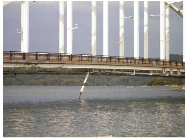
写真 5.3.2 万石橋添架管の被災状況
