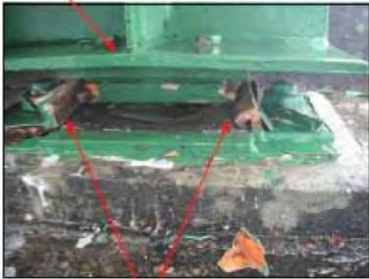
トラス水管橋
