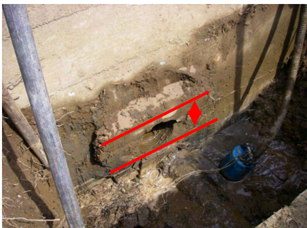
■浄水池越流管の折損状況（地盤沈下による） ■液状化による沈下（右側は浄水池）
