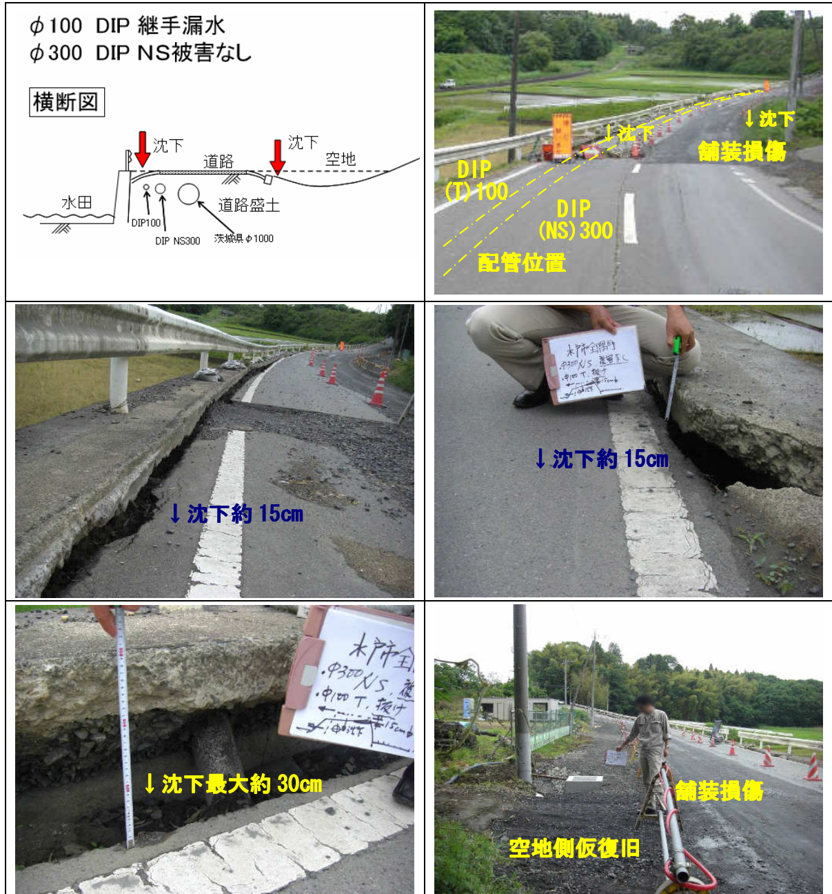
図 2.1.39 道路盛土部の地盤変状の事例 (φ100 DIP(T)継手漏水、φ300 DIP(NS) 被害なし：水戸市全隈町内)
