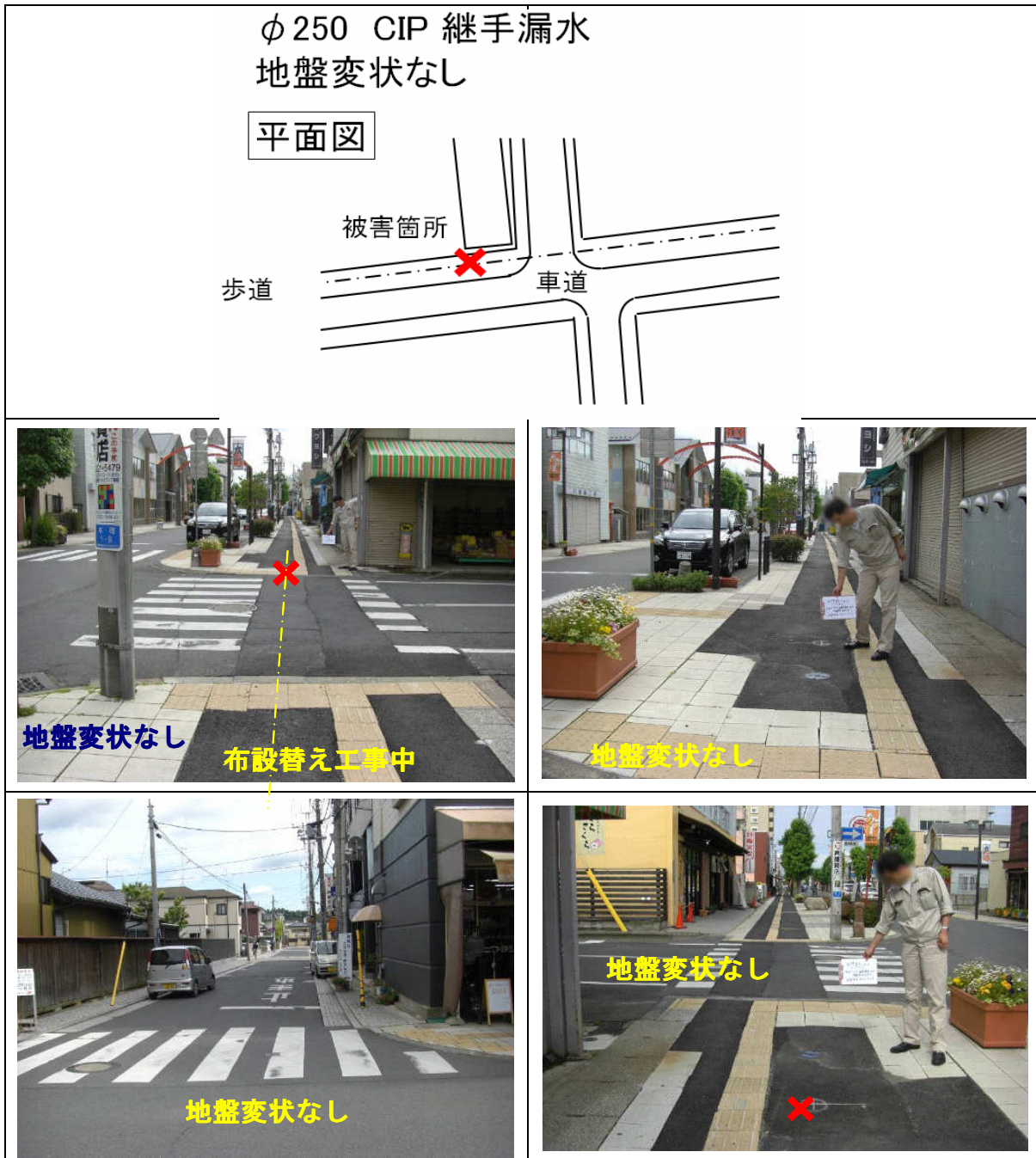
図 2.1.40 鑄鉄管の被害事例( \phi 250 CIP 継手漏水 : 水戸市本町)
