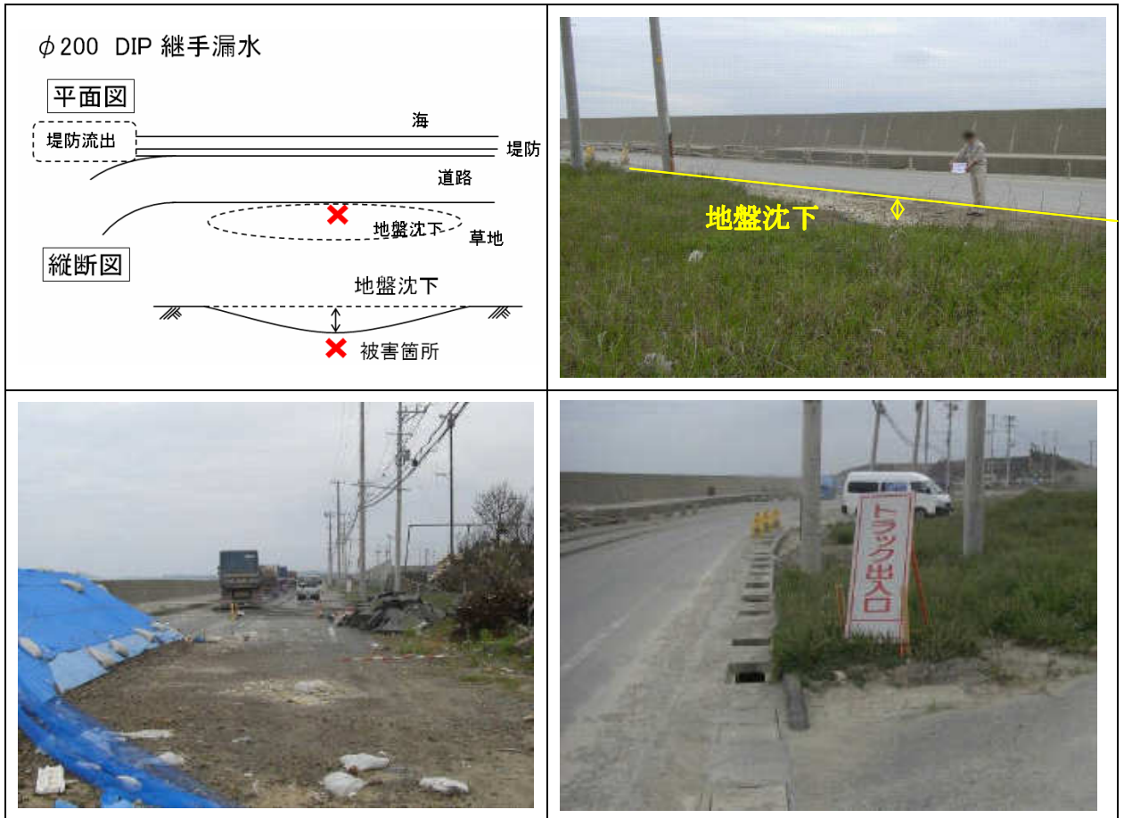
図 2.1.28 宅地造成地での被害例(φ200 DIP 継手漏水：東松島市大曲字南浜)
