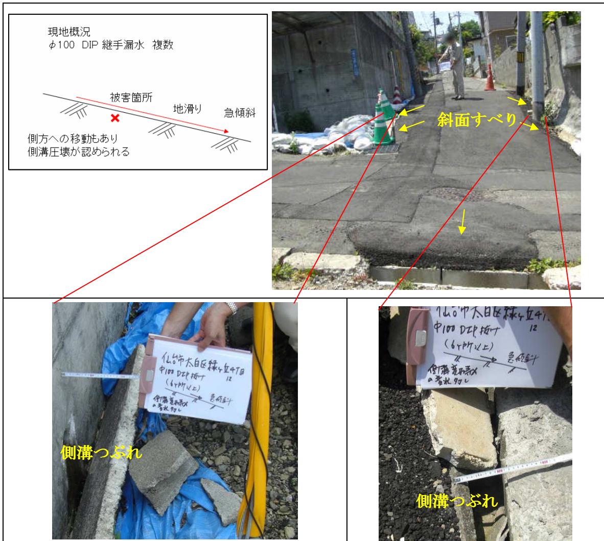
図 2.1.11 管路被害箇所 の地盤状況 (φ100 DIP 継手漏水: 仙台市太白区緑ヶ丘)
