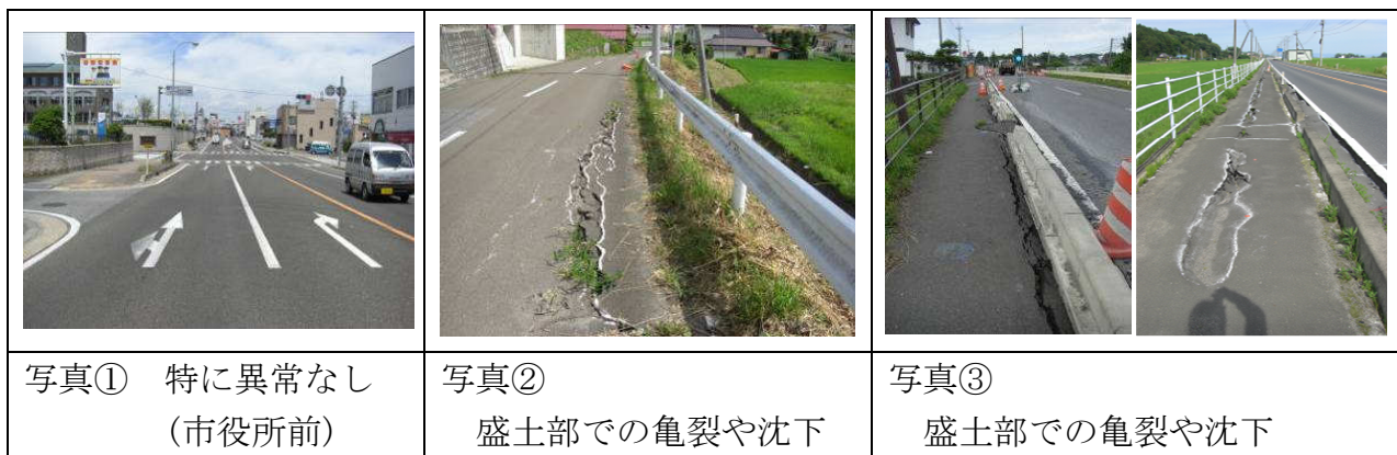
図 2.2.7 栗原市築館地区の道路上の被害状況
