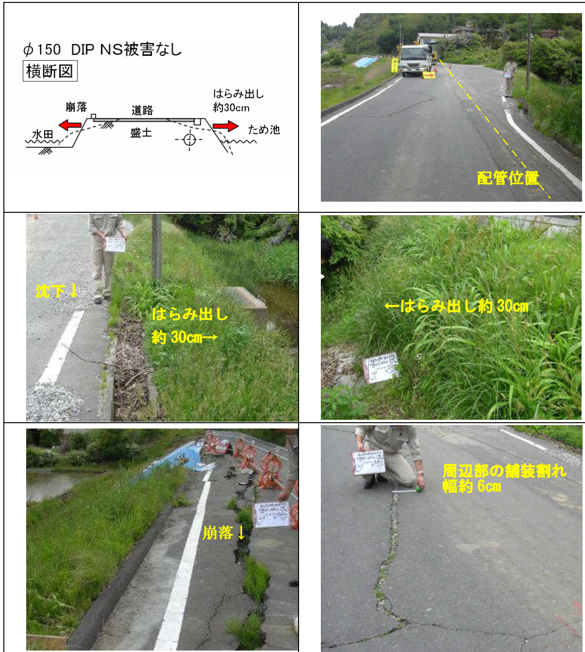
図 2.1.31 道路盛土部の地盤変状の事例 ( \phi 150 DIP(NS) 被害なし: 東松島市新餅田)
