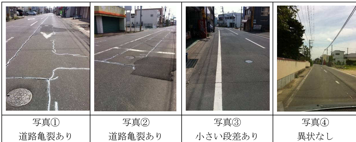
図 2.2.27 涌谷町役場周辺の道路上の被害状況
