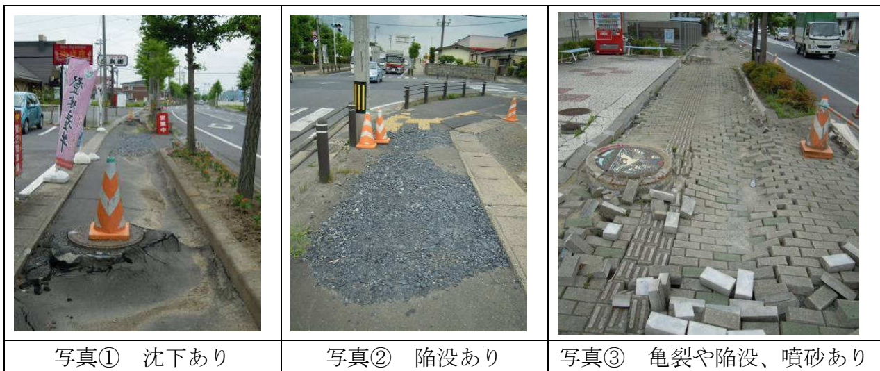
図 2. 2. 20 登米市迫川周辺の道路被害状況
