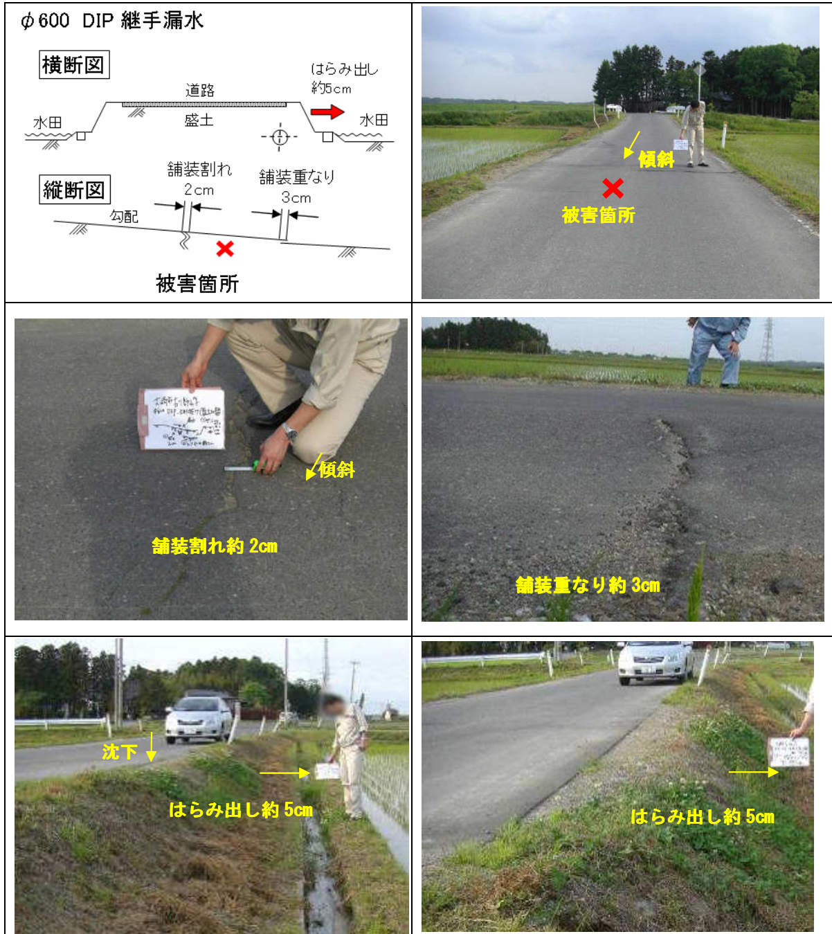
図 2.1.21 道路盛土部の被害事例(φ 600 DIP 継手漏水 : 大崎市内)
