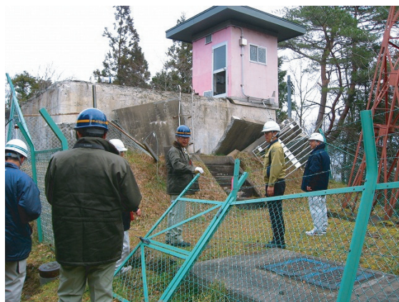
写真 5.6 小豆畑配水池被害状況
