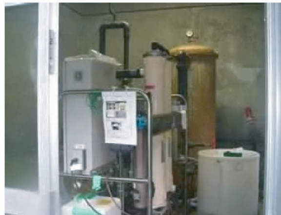
写真 5.9 栗原市山口飲料水供給施設（栗駒地区） 仮設簡易膜ろ過ユニット設置状況
