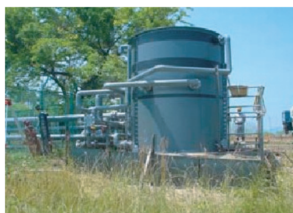
写真5.5 衣川簡易水道ろ過機設置状況
