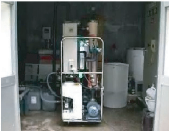
写真 5.9 栗原市山口飲料水供給施設（栗駒地区） 仮設簡易膜ろ過ユニット設置状況
