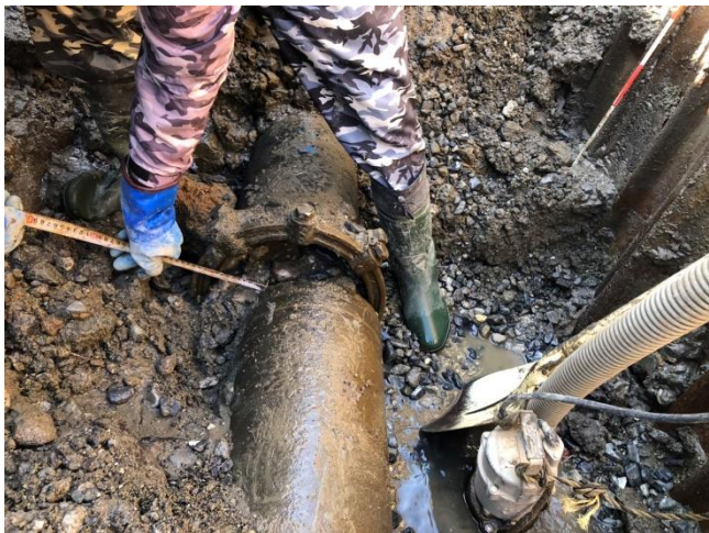
①-121 : φ 250DIP (継手離脱)
