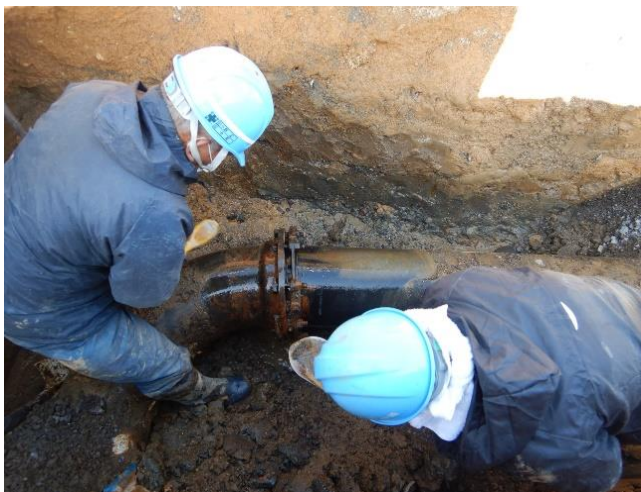
①-95 : φ300DIP (継手離脱)
