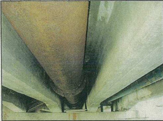
猿候川水管橋 設置年:S40 管種: \phi 800SP
