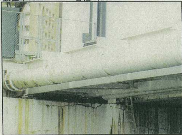
比治山橋添架管 設置年:S32 管種:φ500SP
