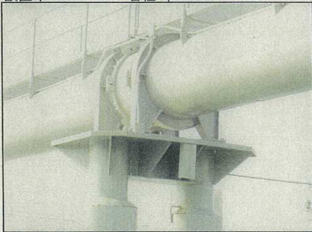
仁保橋添架管 設置年:S39 管種: \phi 500SP
