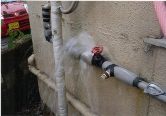
給水管の破損
