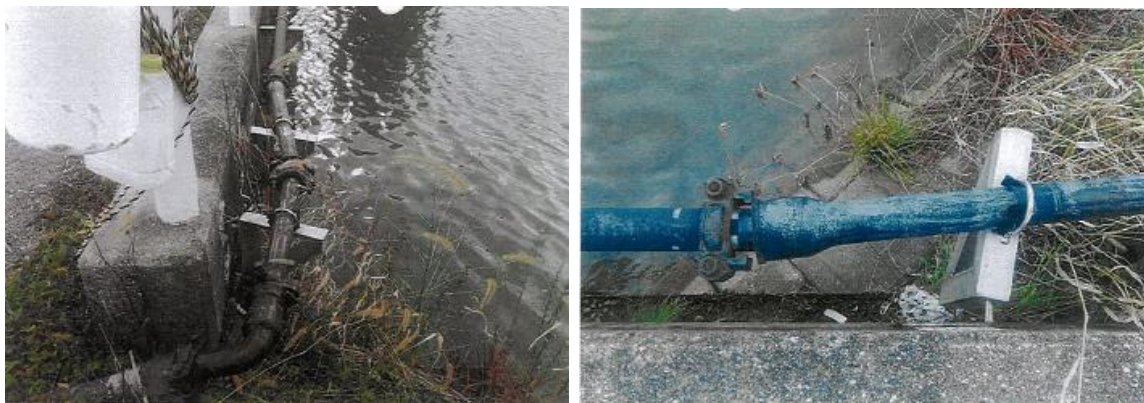
継手箇所の漏水
