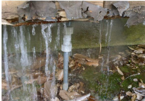
給水管の破損
