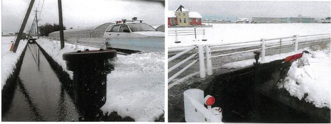
空気弁の破損
