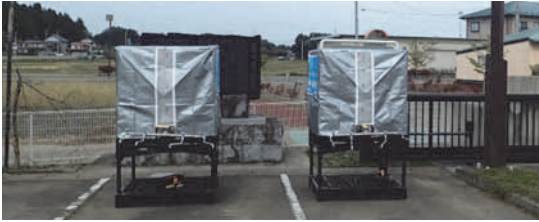
図-2 仮設水槽の設置状況
