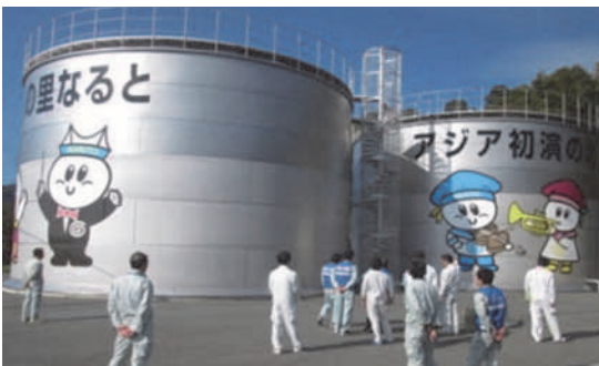
写真-3 給水基地（配水池）の視察（鳴門市）
