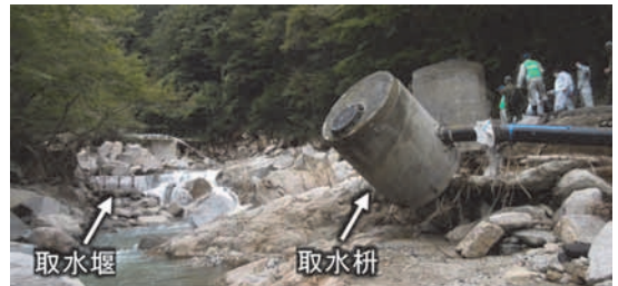
図-1 丸森町石羽浄水場の取水施設
