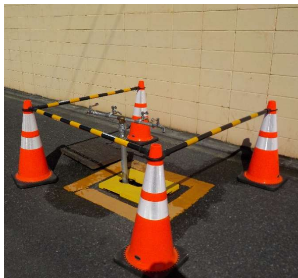
消火栓からの応急給水②
