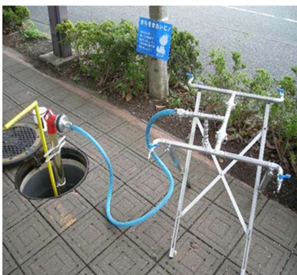
消火栓からの応急給水①
