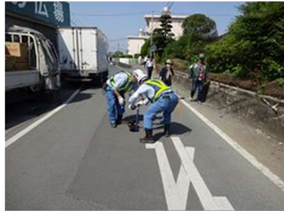
漏水調査作業（バルブ操作）の様子
