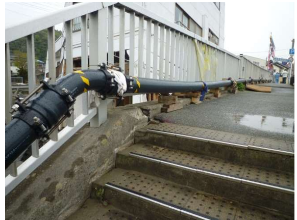
仮設配管(硬質塩化ビニル管)
