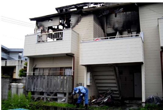
漏水調査作業の様子
