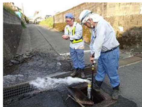
漏水調査作業（管洗浄）の様子
