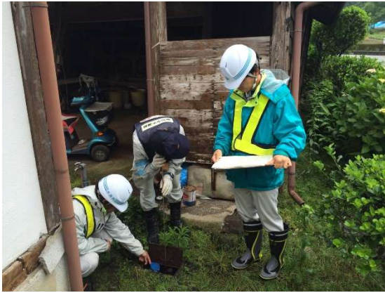
漏水調査作業の様子
