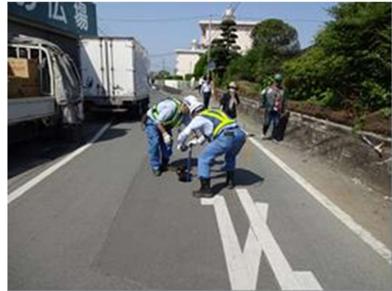
漏水調査作業（バルブ操作）の様子
