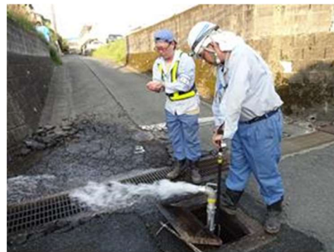
漏水調査作業(管洗浄)の様子
