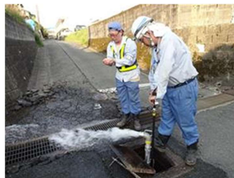
漏水調査作業（管洗浄）の様子
