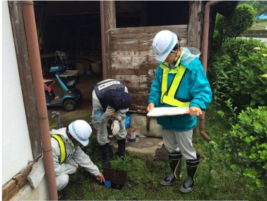
漏水調査作業の様子
