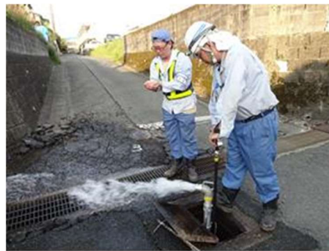
漏水調査作業（管洗浄）の様子
