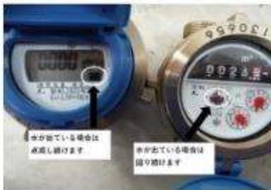
矢印の部分が点滅もしくは回転し続けている場合は、漏水の可能性あります。
