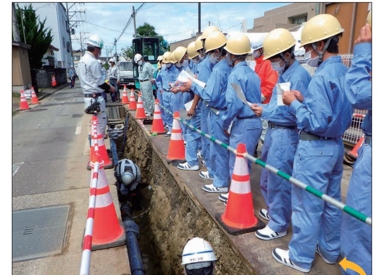
現場見学：工事箇所見学
