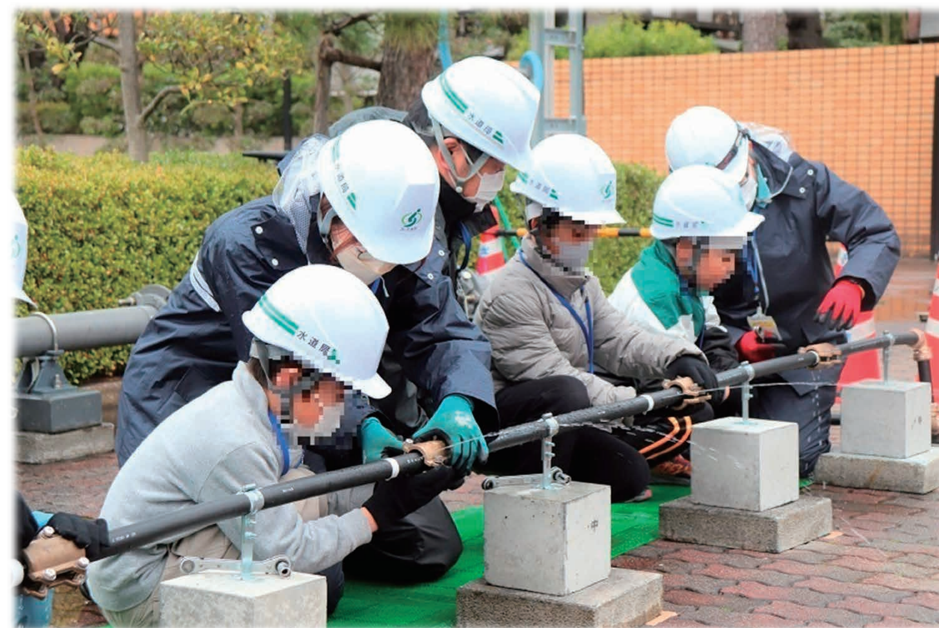
漏水修繕の様子
