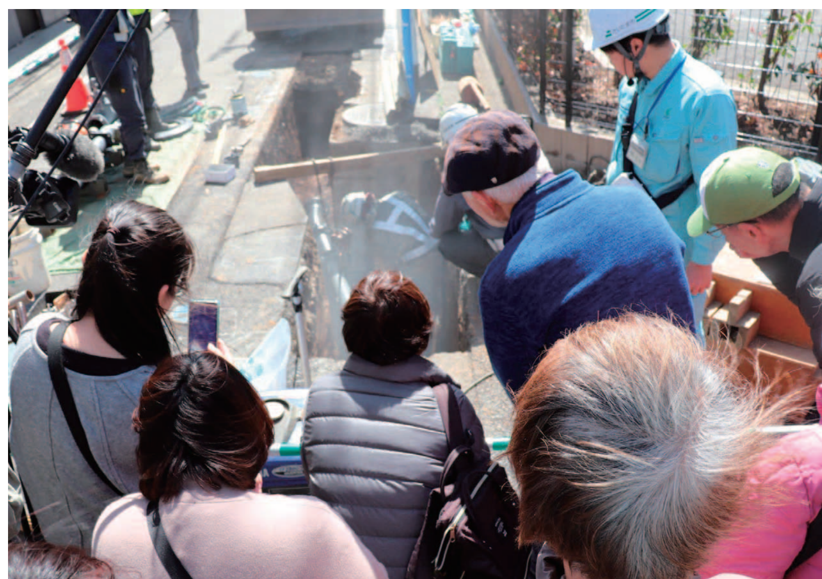
工事現場見学の様子
