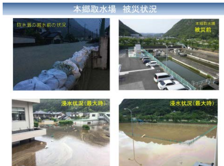
図 5-6 被災した本郷取水場
