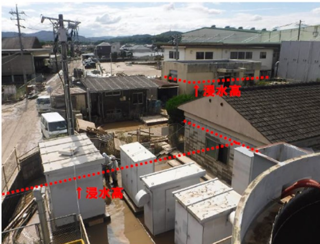
写真 3-5 浄水場への浸水（岡山県倉敷市：真備浄水場）
