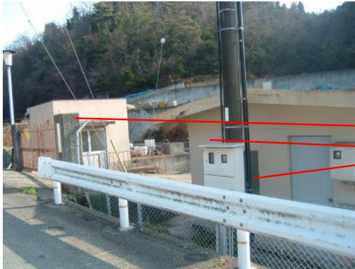
1 柳迫第一ポンプ所 ポンプ室(左)・電気室(右) 被災前
