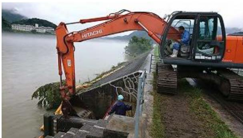
写真 3-11 取水口からのゴミ上げ作業（広島県広島市安佐北区落合：高陽取水場）
