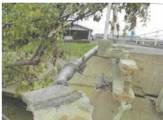
写真 4-11 水流による河川堤防の崩壊により添架管取付部の継手の抜出し (倉敷市真備町有井：大日橋添架管)
