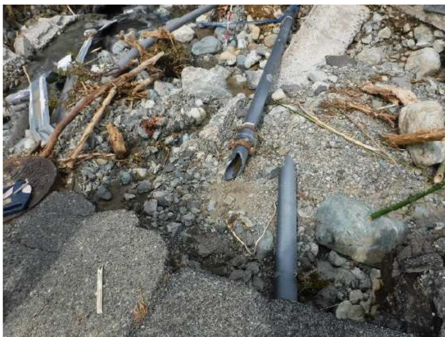
写真 4-4 配水管の破損 (兵庫県宍粟市一宮町河原田)
