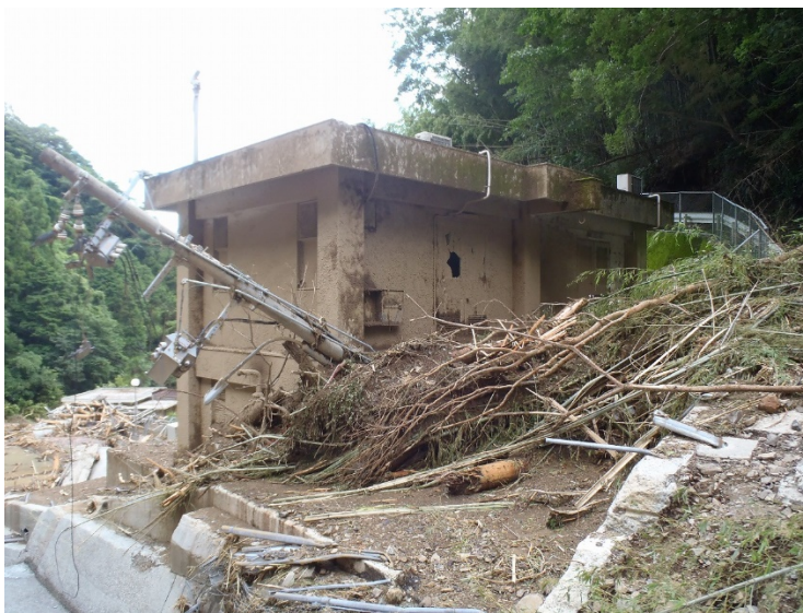
写真 3-18 発電機室背面（愛媛県宇和島市吉田町：吉田浄水場）
