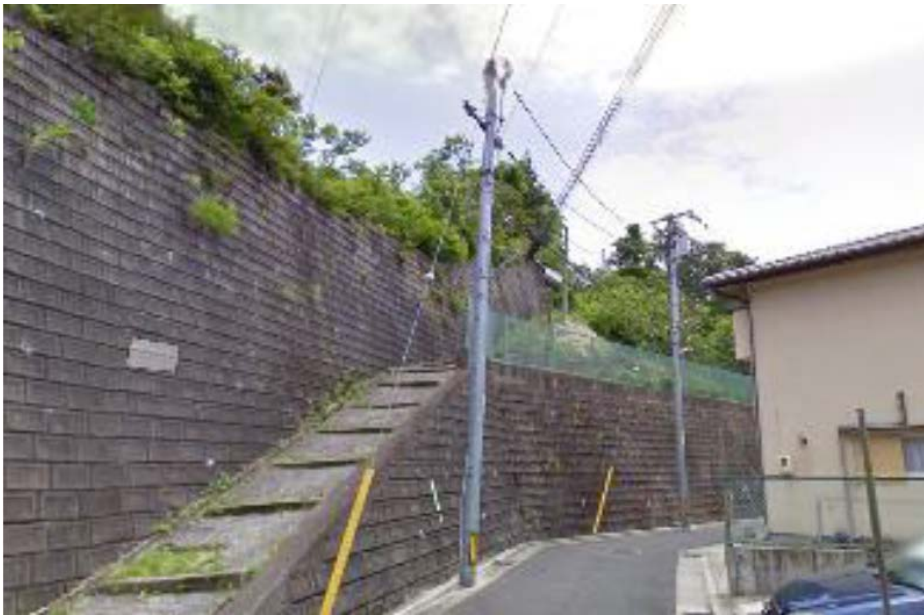
被災前（進入路から配水池方面を撮影）
