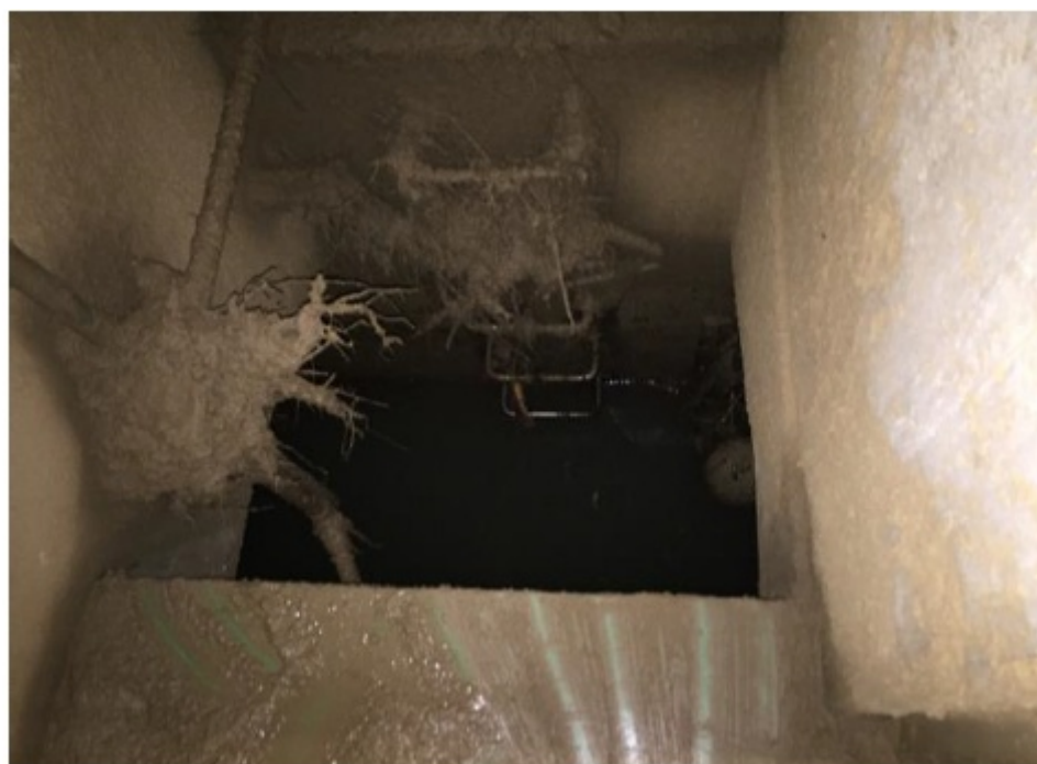
写真 3-33 進入口からの土砂の流入（安芸区畑賀町：畑賀第二調整池）
