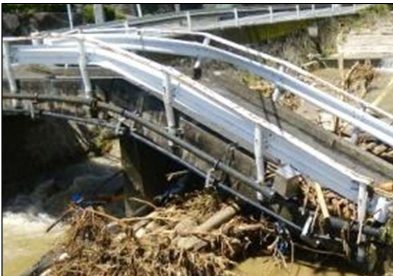
管路状況（大きな傷や継手の抜出しなし）
