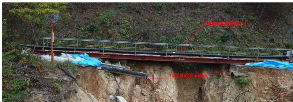
写真 4-8 林道の崩落による管路の流失・被災管と仮設配管(広島県三原市本郷町船木)
