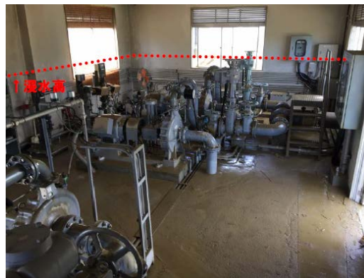
写真 3-6 送水設備室への浸水（岡山県倉敷市：真備浄水場）
