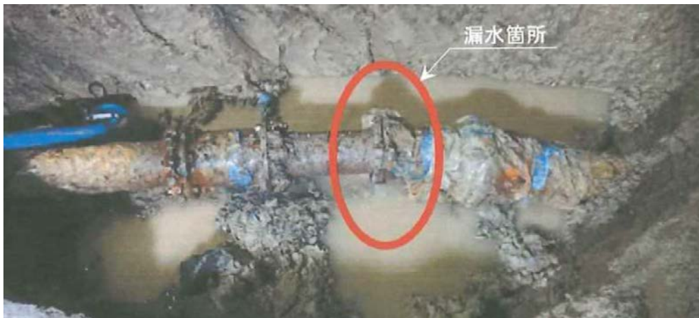
写真 4-9 土石流による継手の破損（兵庫県神戸市垂水区名谷町）
