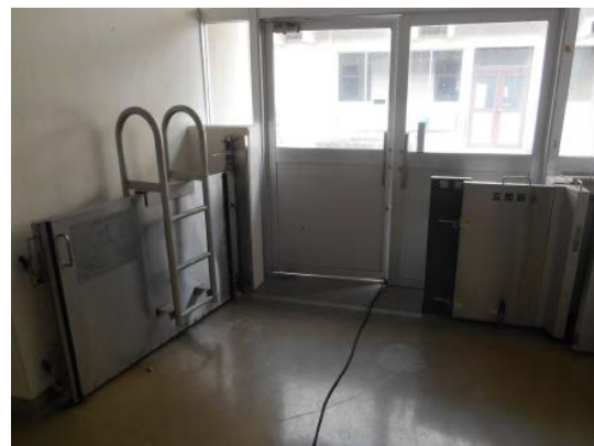
写真 7-4 防水壁（平成 30 年 7 月豪雨以前に実施；山口県周南市：菊川浄水場）
