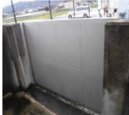
→ 施設の防水扉
