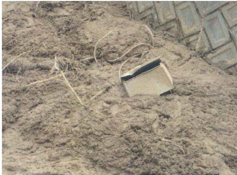
写真 3-38 水位計破損（収納ボックス）（今治市吉海町：田浦配水池）
