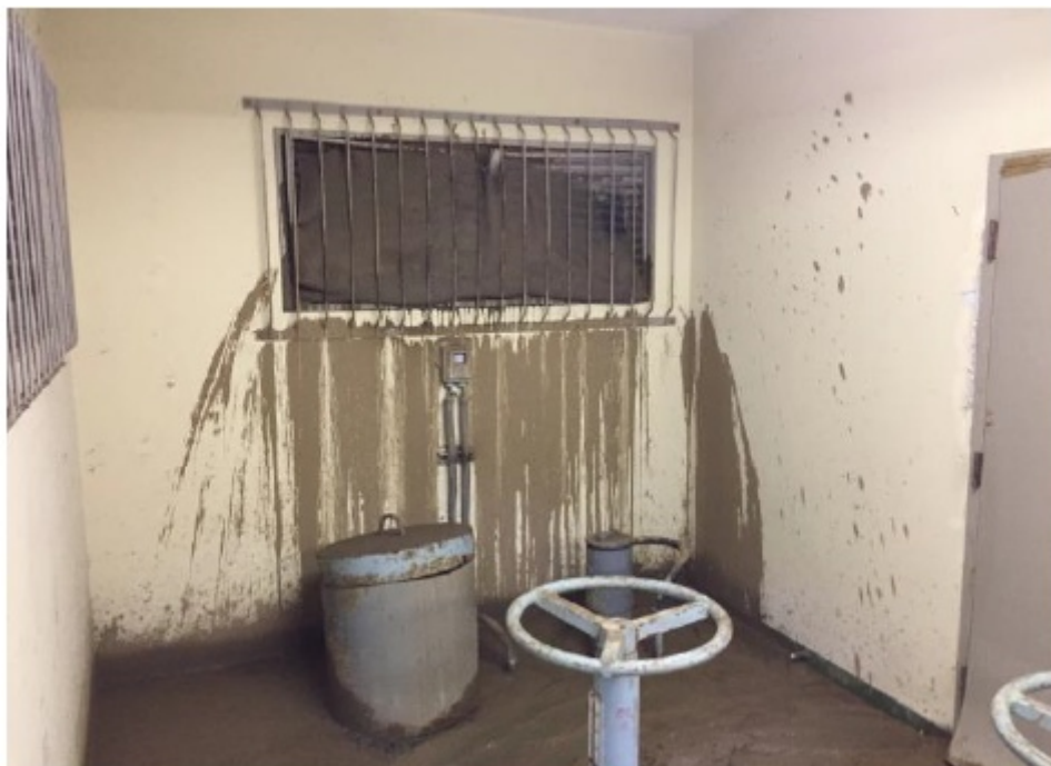
写真 3-32 上屋の窓からの土砂の流入（安芸区畑賀町：畑賀第二調整池）
