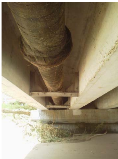
写真 4-13 被災管(広島県広島市安佐北区:鳥声橋添架管)
