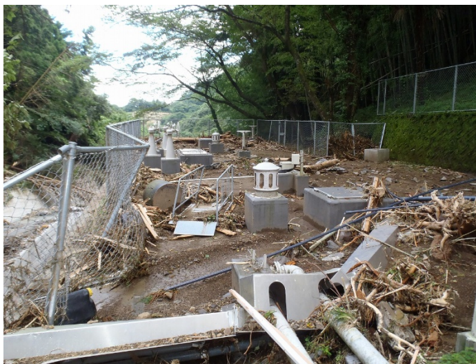
写真 3-21 浄水池（愛媛県宇和島市吉田町：吉田浄水場）
