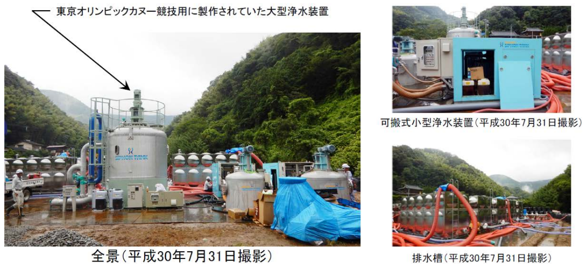
図 5-13 吉田地区仮設浄水設備
