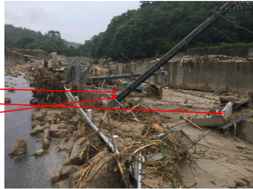
1 柳迫第一ポンプ所 ポンプ室(左)・電気室(右) 被災後
