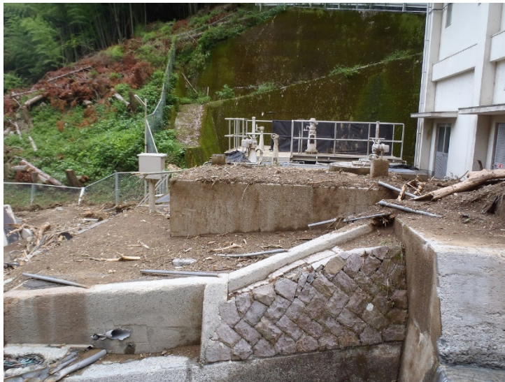
写真 3-17 活性炭混和池・導水流量計（愛媛県宇和島市吉田町：吉田浄水場）
