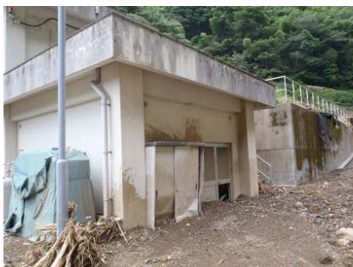
写真 3-23 電気室（愛媛県宇和島市吉田町：吉田浄水場）
