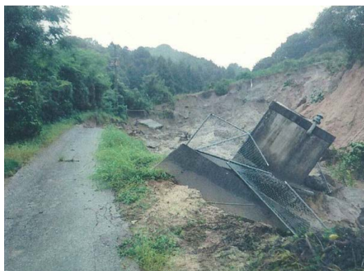
写真 3-41 減圧水槽用地の地盤崩落（今治市菊間町：西山減圧槽（配水施設））
