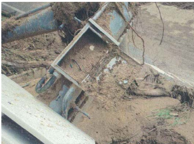
写真 3-36 電気計装盤等の破壊（愛媛県今治市吉海町：田浦配水池）
