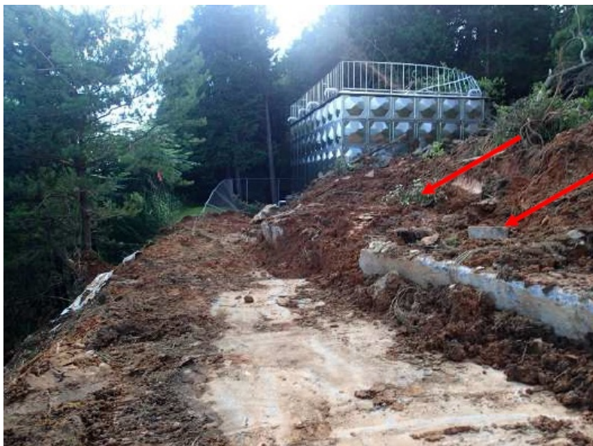
写真 3-40 隣接地からの土砂流入②(兵庫県宍粟市千種町鷹巣:内海第2配水池)
