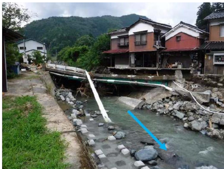
写真 4-14 落橋と添架管の破損 (兵庫県宍粟市一宮町河原田)
