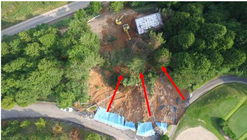
写真 3-39 隣接地からの土砂流入①(兵庫県宍粟市千種町鷹巣:内海第2配水池)
