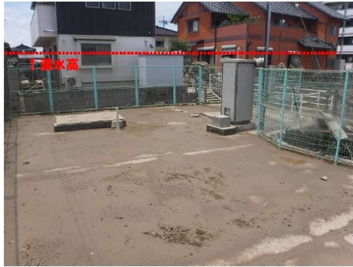
写真 3-7 取水井全景（岡山県倉敷市：真備 No.4 取水井）
