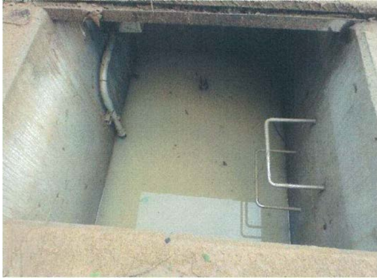
写真 3-37 流量計浸水（水没）（今治市吉海町：田浦配水池）
