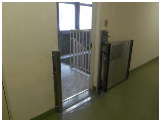
写真 7-4 防水壁（平成 30 年 7 月豪雨以前に実施；山口県周南市：菊川浄水場）
