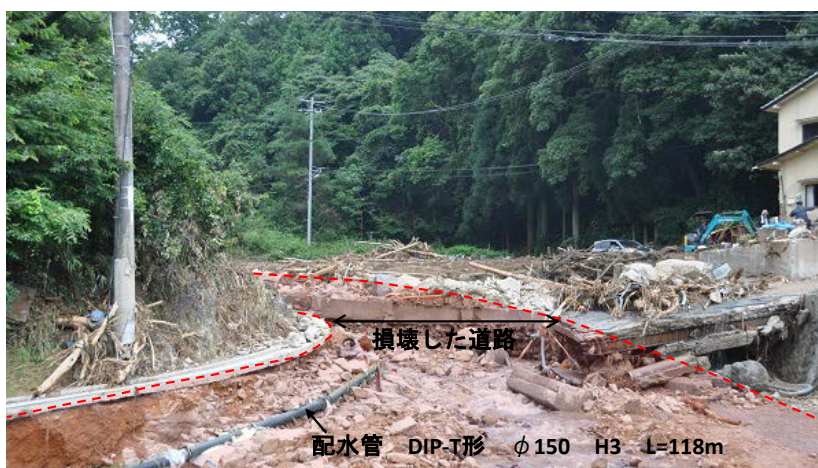
写真 4-1 道路の崩壊による埋設管路の露出と継手の離脱（広島市安芸区上瀬野町）
