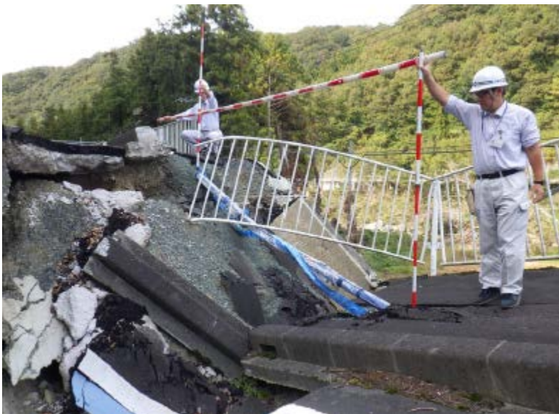
HPPE 管露出部
