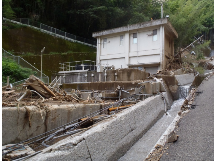
写真 3-16 発電機室前面・活性炭混和池（愛媛県宇和島市吉田町：吉田浄水場）
