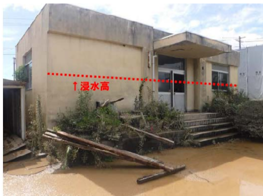
写真 3-6 送水設備室への浸水（岡山県倉敷市：真備浄水場）
