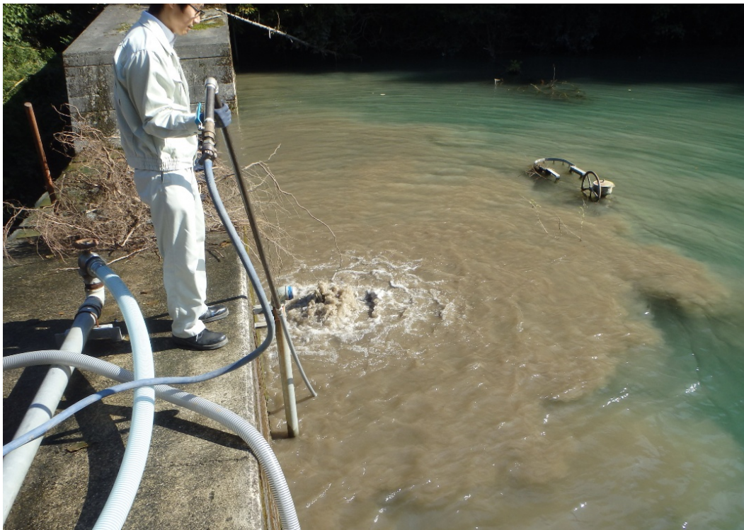
写真 3-42 取水口に流入した土砂をコンプレッサで除去 (愛媛県今治市朝倉：峠浄水場)
