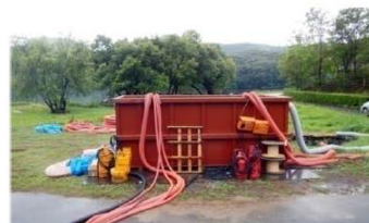
原水槽(平成30年7月31日撮影) ～ 原水は農業用ため池 ～
