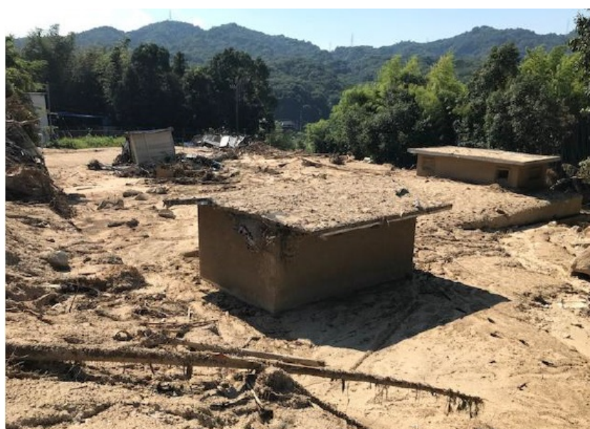
写真 3-31 被災後 配水池 敷地内（安芸区畑賀町：畑賀第二調整池）
