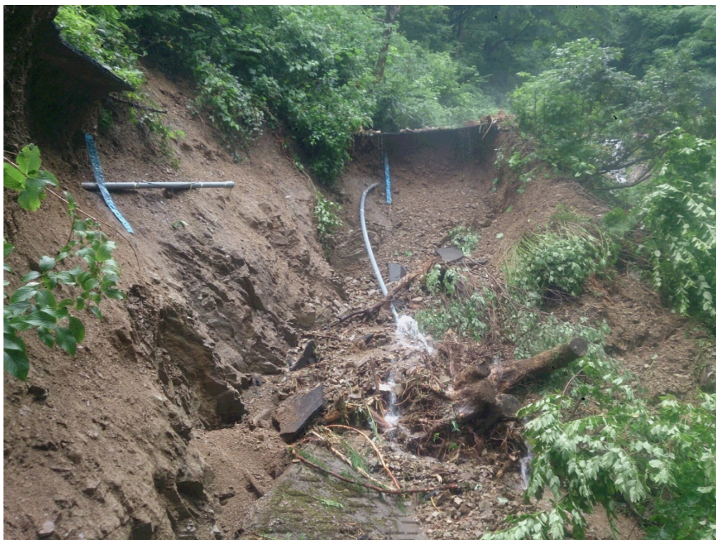
写真 4-10 林道の崩壊により管体が破損（岐阜県飛騨市古川町戸市）
