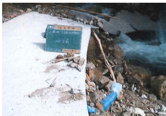
写真 4-6 橋梁の流失に伴う添架管の管体破断 (愛媛県宇和島市三間町川之内)
