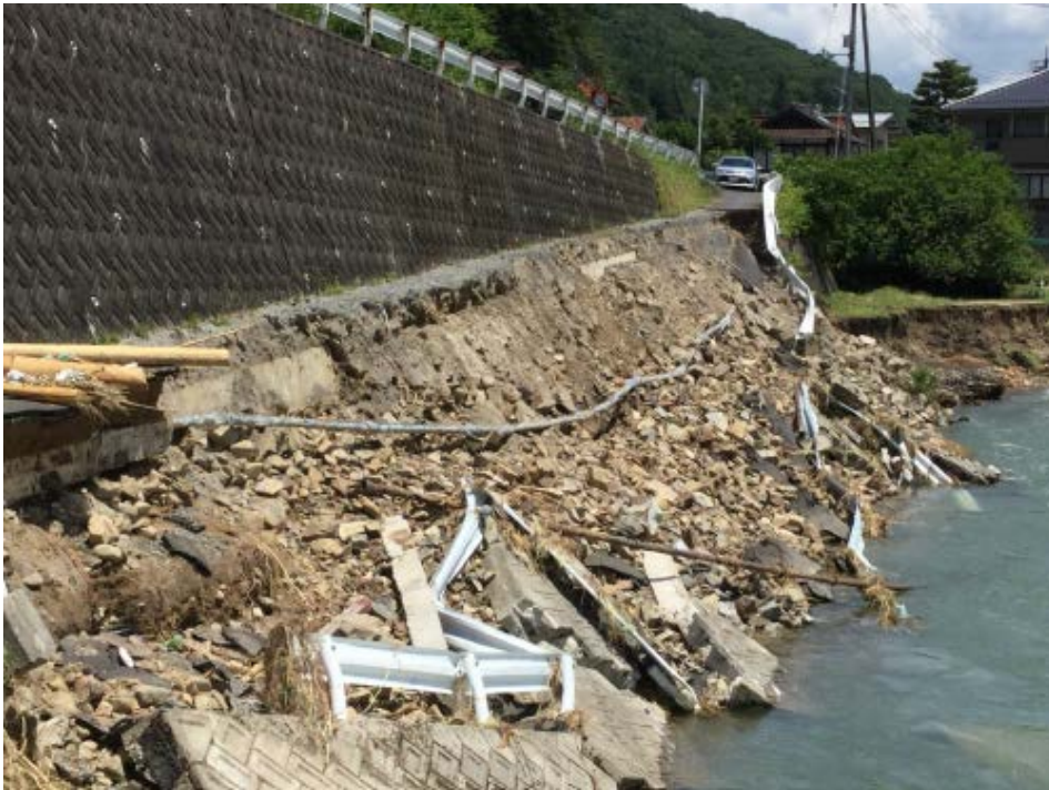
管路状況（大きな傷や継手の抜出しなし）
