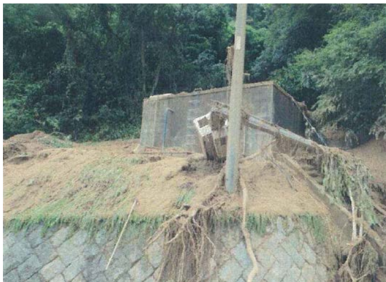
写真 3-35 土石流による被害（愛媛県今治市吉海町：田浦配水池）
