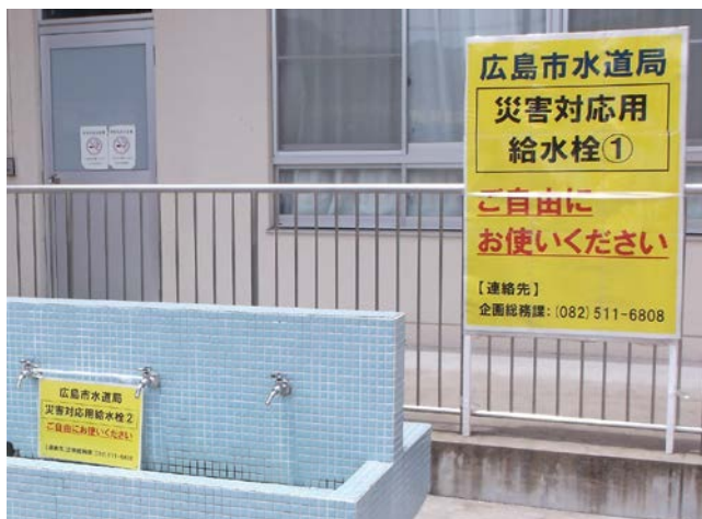
写真 5-7 災害対応用給水栓（広島市）
