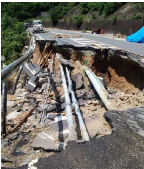
現場状況 (道路崩落)
