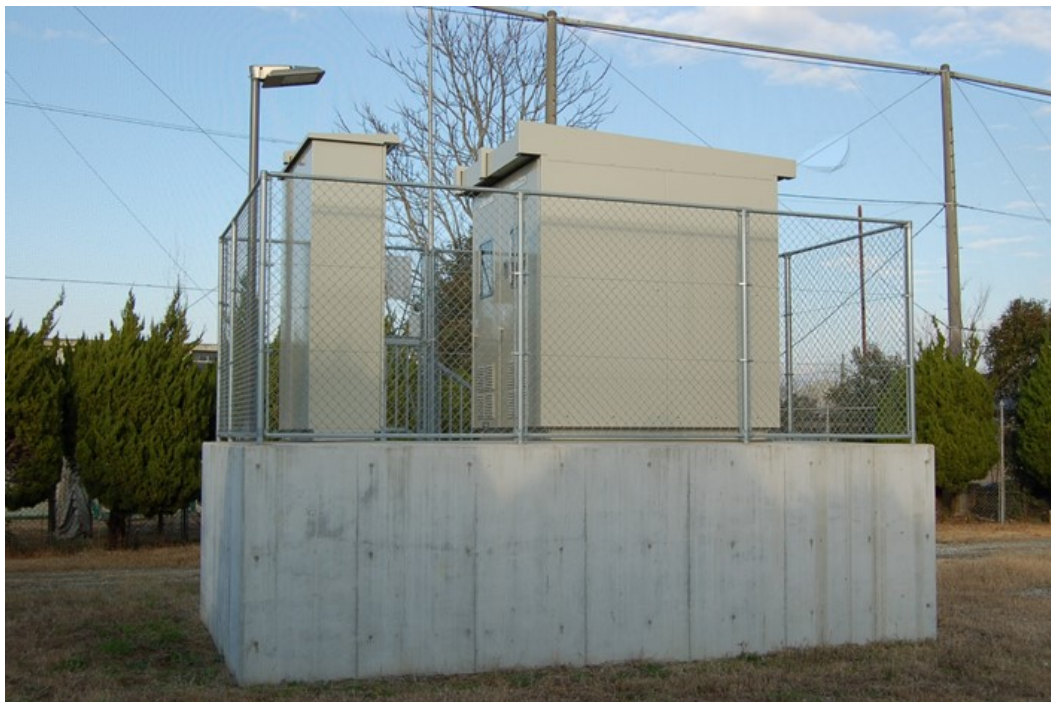
写真 7-8 取水受変電盤基礎の嵩上げ (平成 30 年 7 月豪雨以前に実施；兵庫県高砂市：米田水源地)
