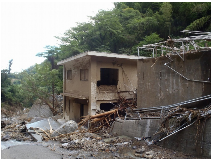
写真 3-20 管理棟・急速ろ過池（愛媛県宇和島市吉田町：吉田浄水場）
