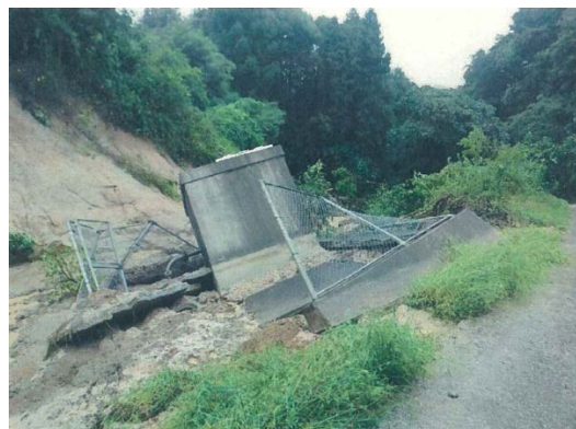
写真 3-41 減圧水槽用地の地盤崩落（今治市菊間町：西山減圧槽（配水施設））
