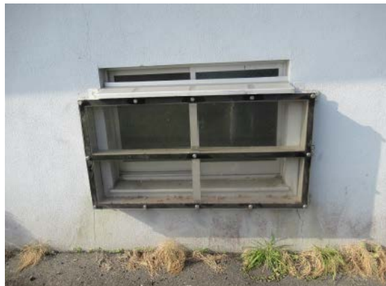
写真 7-5 防水壁（平成 30 年 7 月豪雨以前に実施；山口県周南市：的場ポンプ所）
