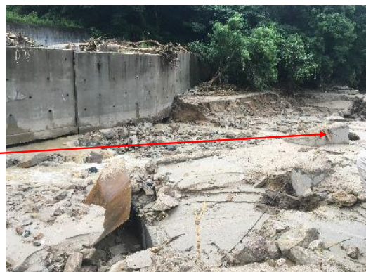
1 柳迫第一ポンプ所 矢印はポンプ井検入口 被災後
