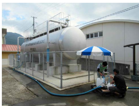
写真 5-8 耐震性貯水槽を使用した給水所
