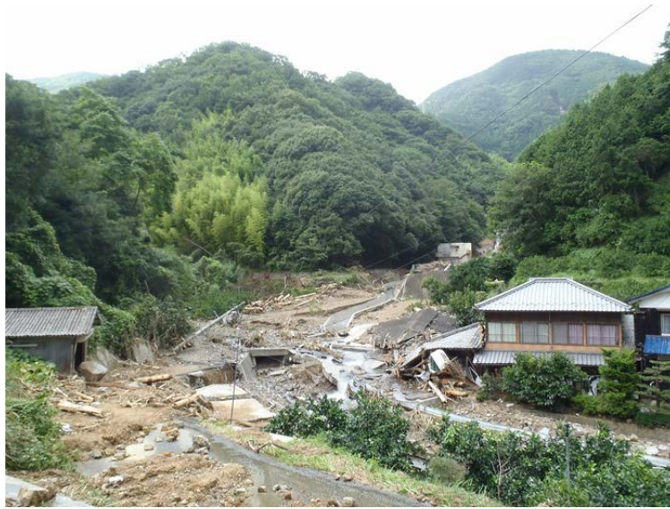
写真 3-25 吉田浄水場 進入路（愛媛県宇和島市吉田町：吉田浄水場）
