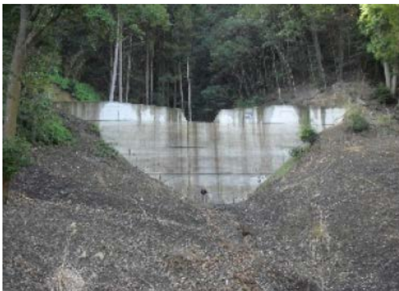
No.2 谷止工 L=25m H=8m
