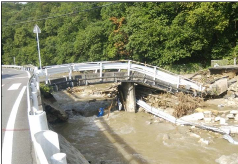
現場状況（橋梁崩落）
