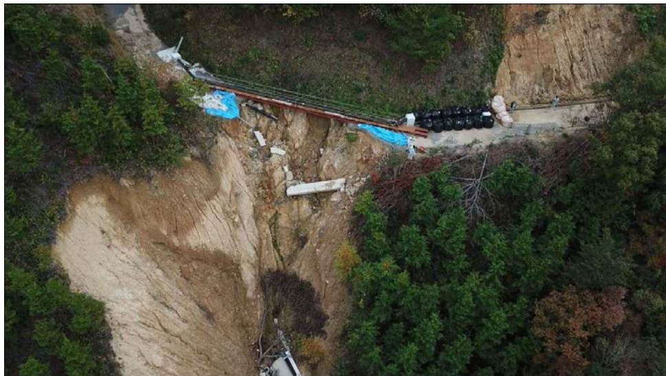
写真 4-7 林道の崩落による管路の流失(広島県三原市本郷町船木)
