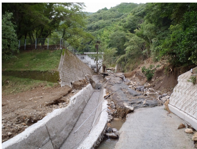
写真 3-22 浄水池横（愛媛県宇和島市吉田町：吉田浄水場）
