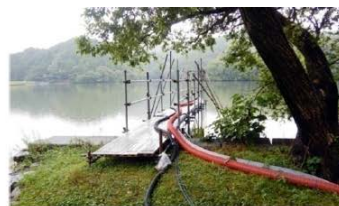
原水取水点(平成30年7月31日撮影)
