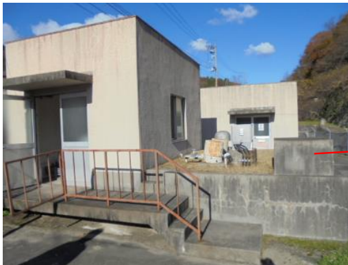
1 柳迫第一ポンプ所 矢印はポンプ井検入口 被災前
