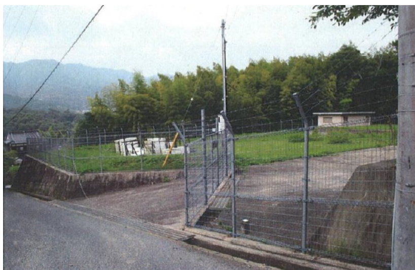
写真 3-30 被災前 配水池上屋（安芸区畑賀町：畑賀第二調整池）
