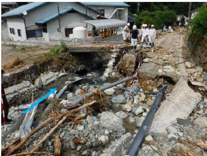
写真 4-3 道路崩壊状況 (兵庫県宍粟市一宮町河原田)
