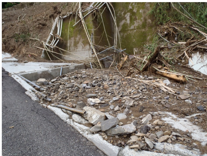
写真 3-19 導水ポンプ場（愛媛県宇和島市吉田町：吉田浄水場）
