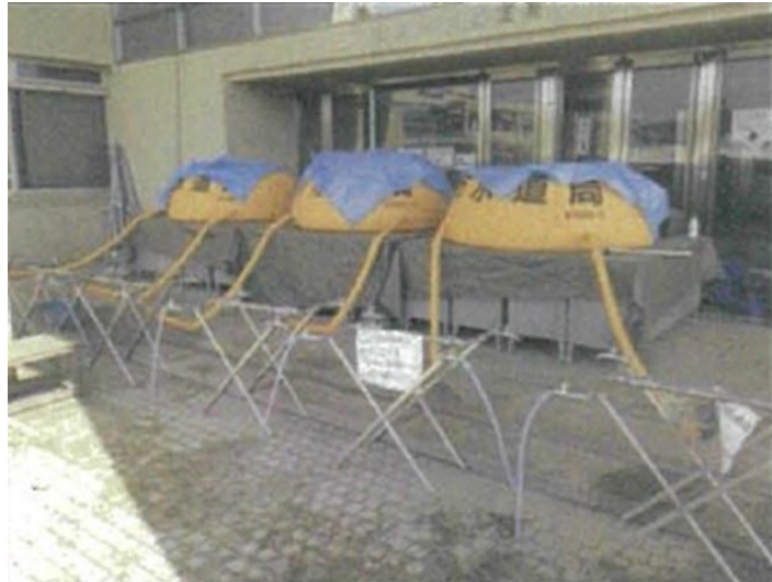
写真 5-4 臨時給水所（倉敷市）
