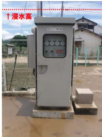
写真 3-8 取水ポンプ動力計装板（岡山県倉敷市：真備 No.4 取水井）
