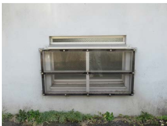
写真 7-5 防水壁（平成 30 年 7 月豪雨以前に実施；山口県周南市：的場ポンプ所）
