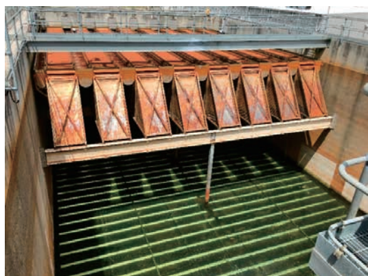
沈澱池 (未稼働)
