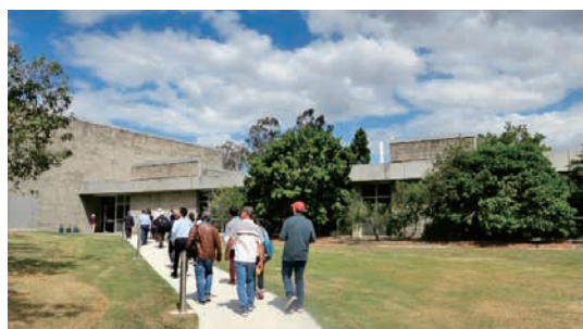
West Bank 浄水場
