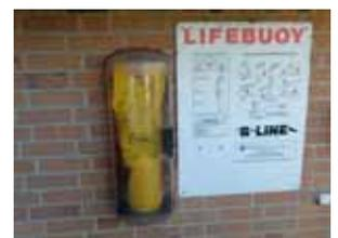
凝集沈殿池に職員が落下した際の救助装置
