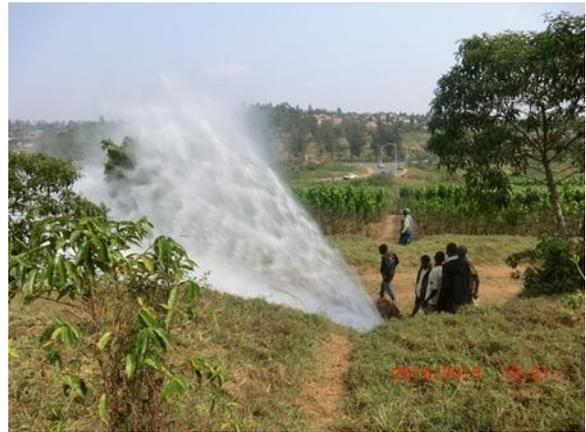
写真5 高水圧エリアにおける漏水
