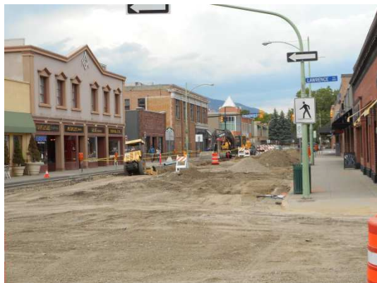
写真13. 施工現場の様子
