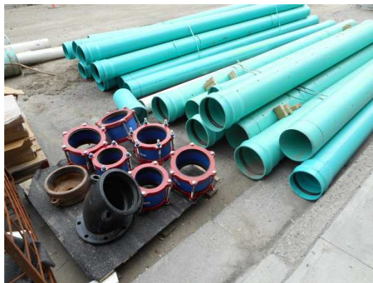
写真14. 使用されているVU管
