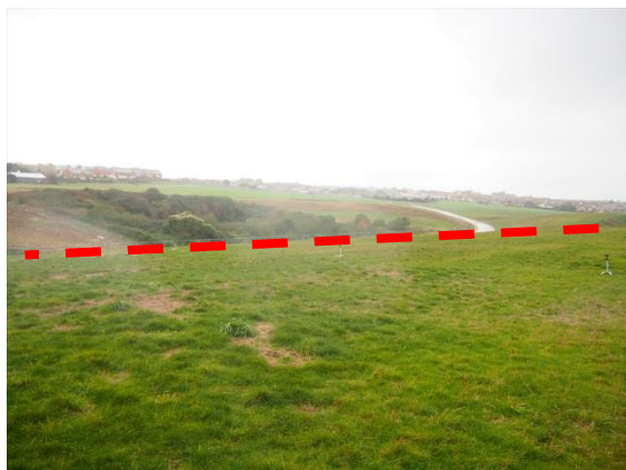
屋上緑化の様子。点線より前が処理プラントの屋根、奥が田園風景。においも感じなかった。
