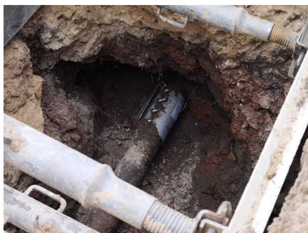
写真 4 漏水修理工事現場状況 1
