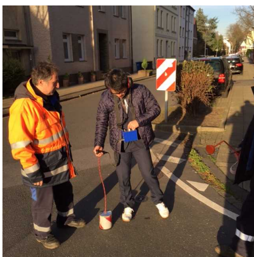
写真 18 漏水探知機による調査
