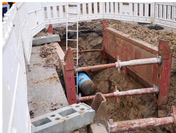
写真 3 布設工事現場状況
