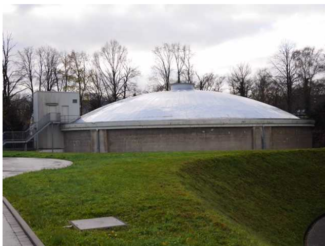
写真 21 Bredeney 配水池外観
