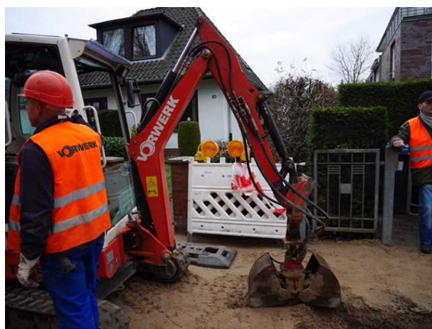
写真 5 漏水修理工事現場状況 2
