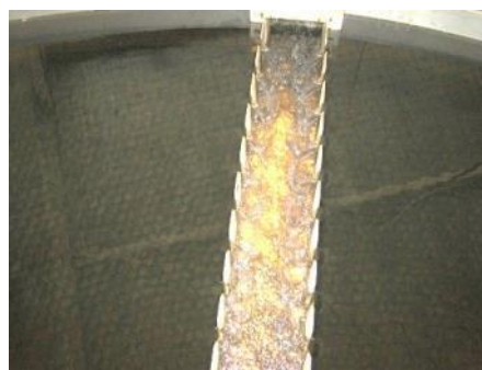
沈殿処理水の状況
