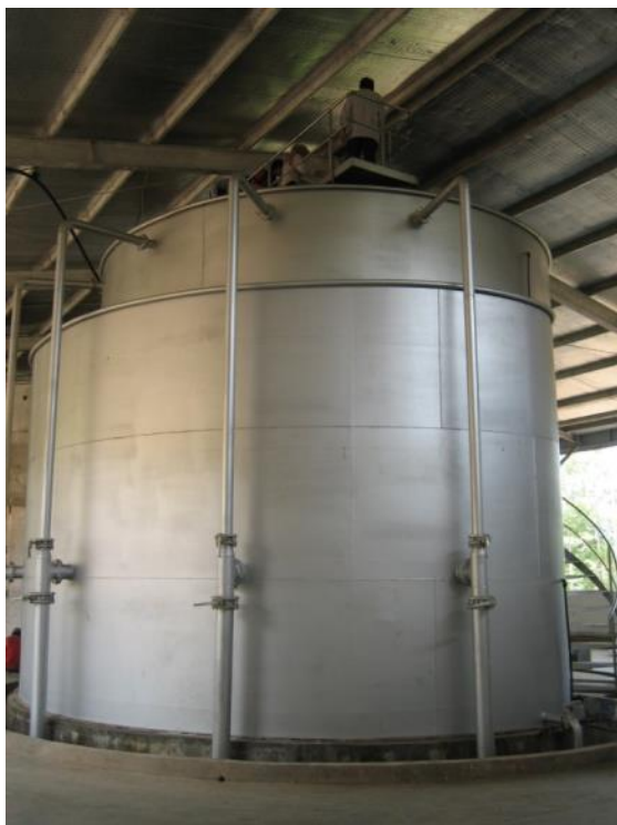
浄水処理システム
