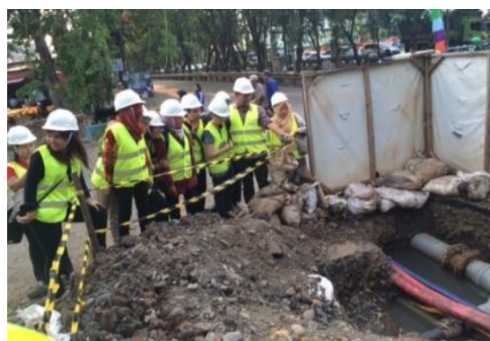
漏水現場視察風景
