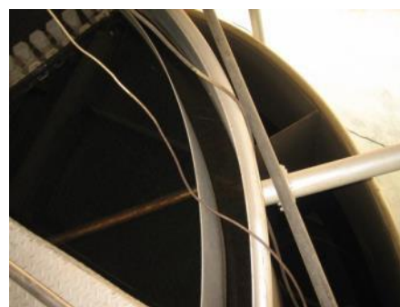
沈殿処理槽 と ろ過処理槽
