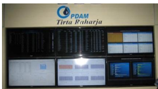
管路監視システム
