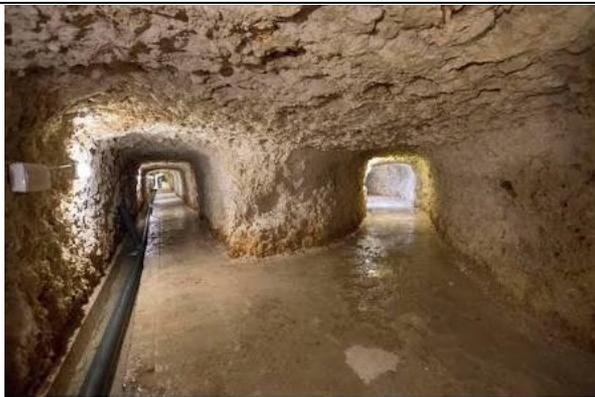
【写真 58：帯水層内の導水トンネル】
