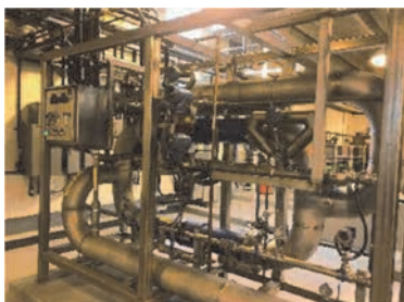
炭酸ガス注入設備
