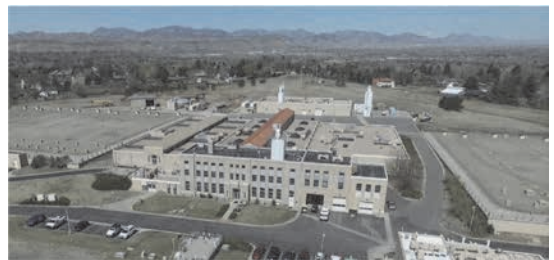
Moffat 浄水場全景
