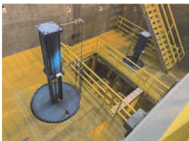
高分子凝集剤注入及び攪拌
