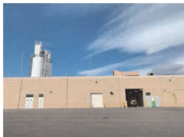
着水井及び凝集剤注入施設
