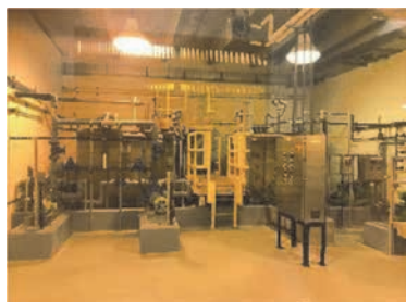
高分子凝集剤薬品室
