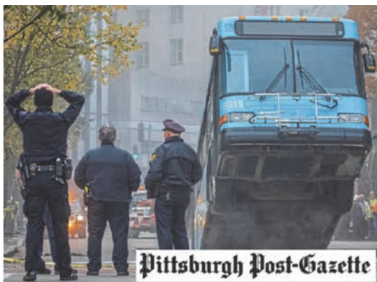
漏水による地盤沈下でバスが転落した様子
