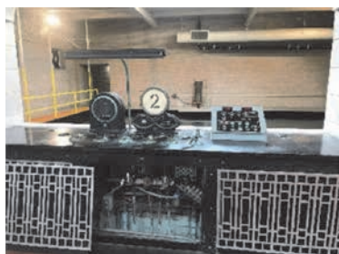
汙過池操作盤
