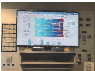
運転監視画面
