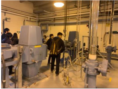
凝集剤注入及びフラッシュミキサー
