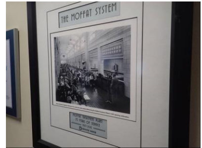
Moffat 浄水場運転開始日の様子
