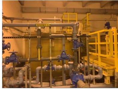
凝集剤注入配管
