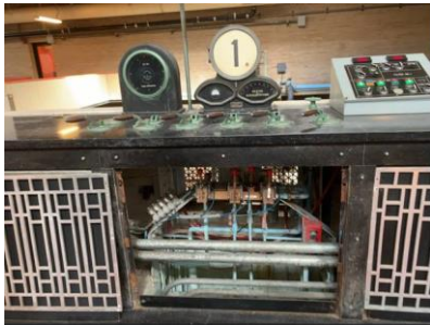
ろ過池制御盤
