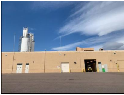
着水井及び凝集剤注入施設
