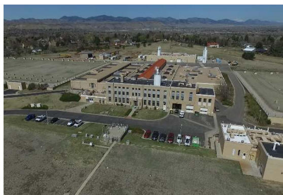
現在のモファット浄水場(デンバーウォーターHPより)
