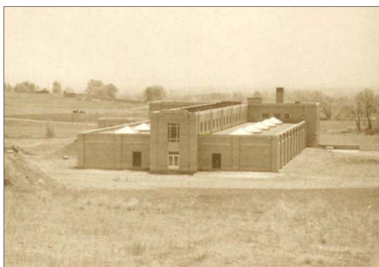
設立当時のモファット浄水場(研修資料より)
