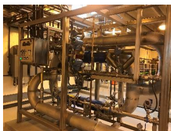
炭酸ガス注入設備
