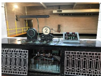
ろ過池操作盤
