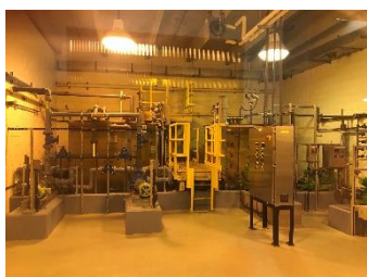
高分子凝集剤薬品室
