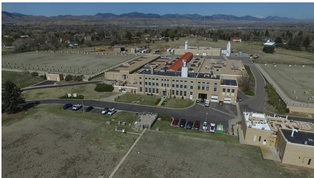
Moffat 浄水場全景
