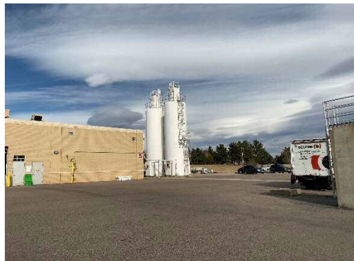
薬品保管施設・タンク
