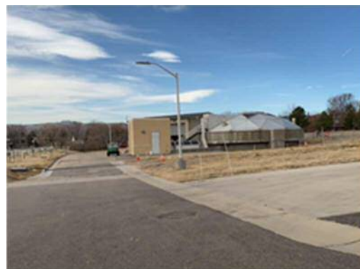
スラッジ処理場
