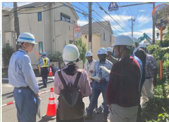
施工現場視察
