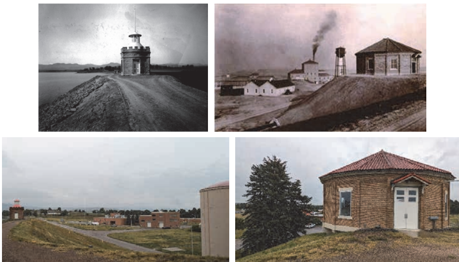
図-21 Marston 浄水場の過去・現在比較 (上段：建設当初、下段：現在)
