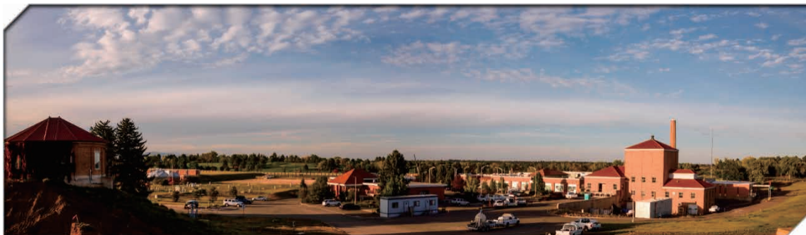
Marston 浄水場全景
