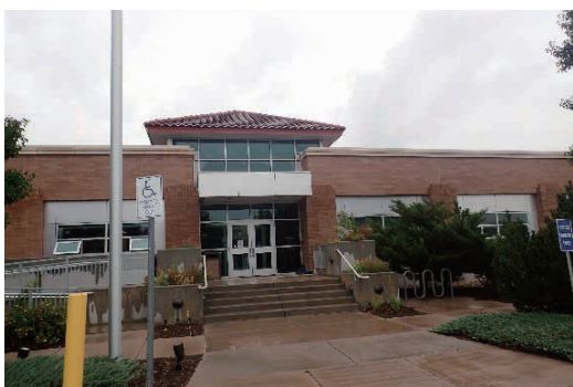
浄水場正面玄関
