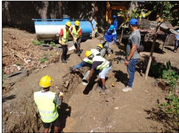
配水管整備工事の様子
