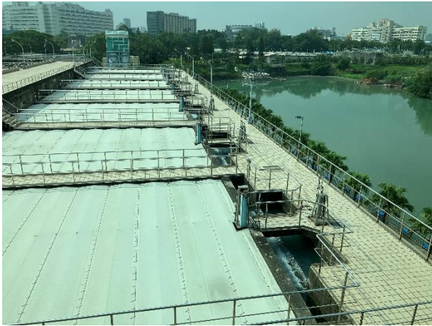
写真-14 砂ろ過池
