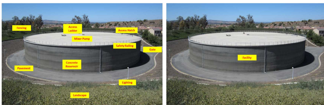
図 8. 立場によるアセットの違い（左：維持管理の視点、右：財務の視点）
