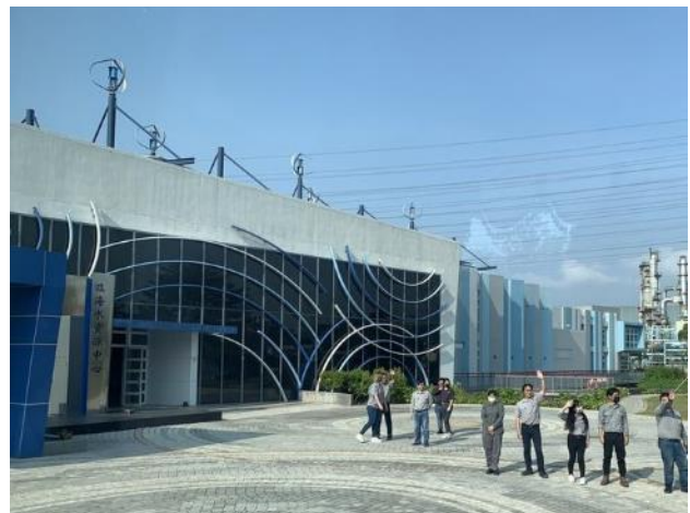
写真-17: 臨海水資源センター
