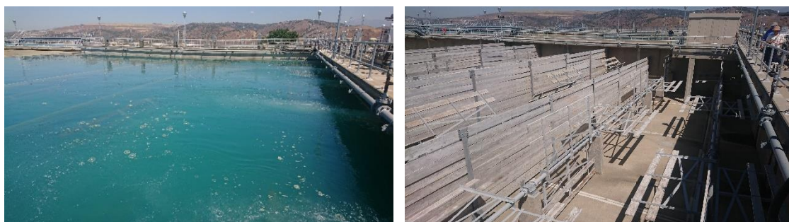
写真 Diemer 浄水場の沈澱池に設置されている円筒型クラリファイア
