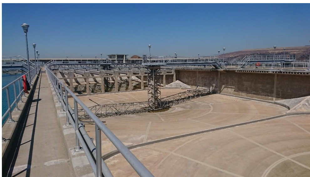
写真 Diemer 浄水場の沈澱池に設置されている円筒型クラリファイア
