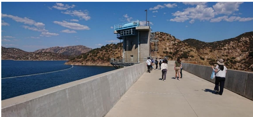
写真 San Vicente ダムの堤体部
