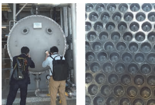
オゾン発生装置
