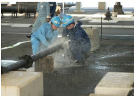
仮想の漏水で実務研修
