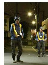
深夜の漏水発見作業
