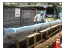
水道管の計画的取替 (ダクタイトイル管取替)
