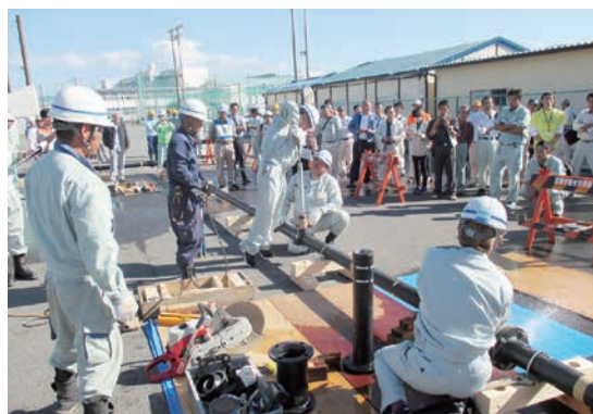
復旧訓練（沼津市）
