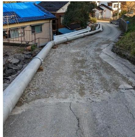
仮設配管の布設例（配水管）
