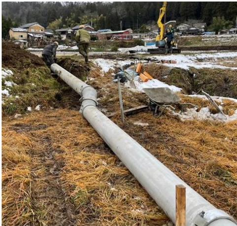
仮設配管の布設例（導水管）
