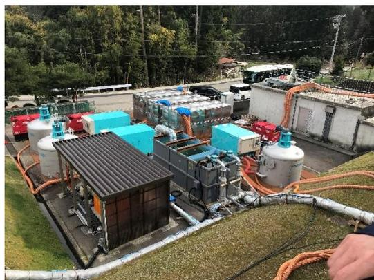
可搬式浄水装置の設置による補水地点の増設
